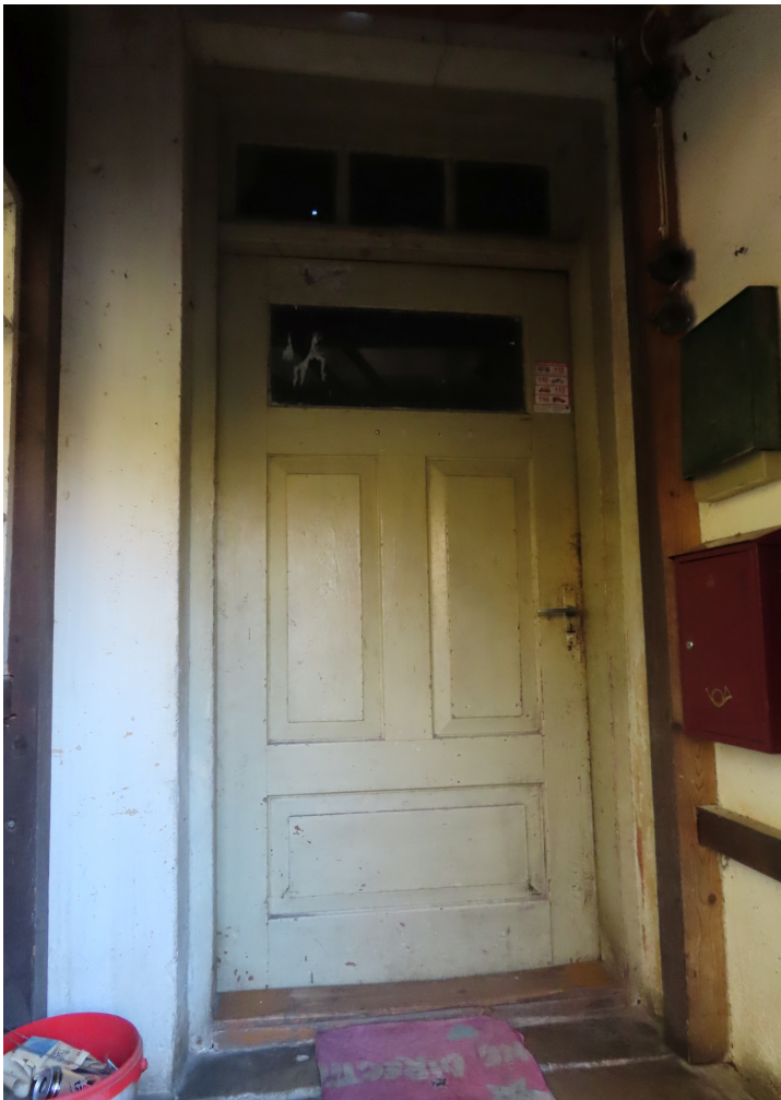
Pilskalna_7_88130010061001_ durvis1 Sākotnējās ieejas durvis (1939.gads) ziemeļrietumu fasādē (pagalma). Piebūve -20.gs. beigas.
