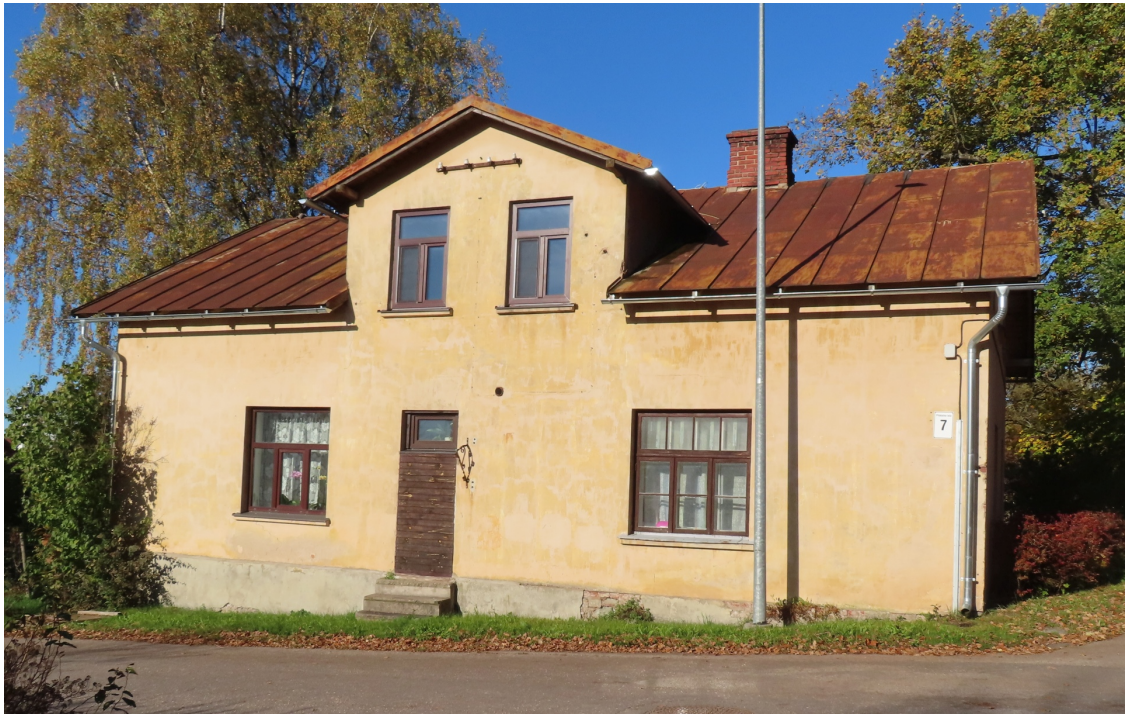
Pilskalna_7_88130010061001_fasade1 Skats uz ēku no dienvidaustrumiem.
