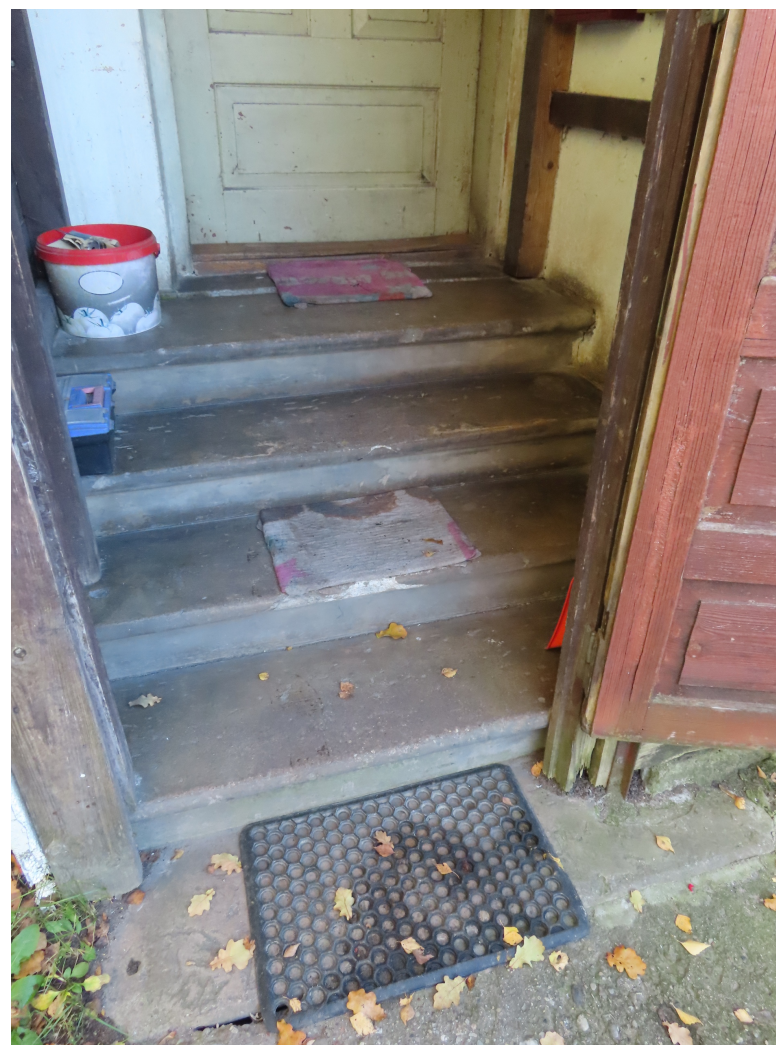
Pilskalna_7_88130010061001_kāpnes1 Sākotnēji vaļējas kāpnes (1939.g.) ziemeļrietumu fasādē (pagalma). Piebūve -20.gs. beigās.
