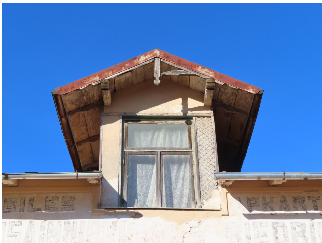
Pilskalna_5_88130010062001_fragments2 Skats uz ēku no dienvidrietumiem. Jumta loga izbūve - 1930.gadi.
