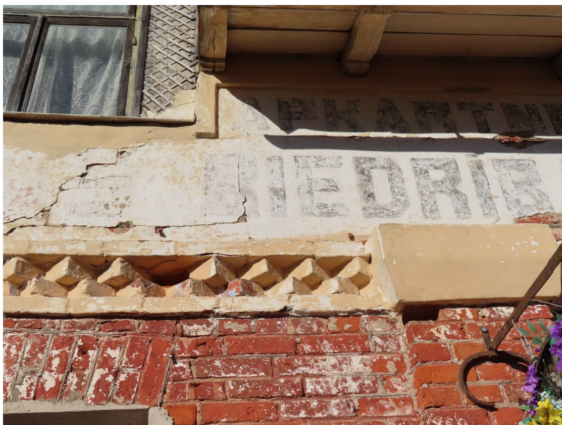
Pilskalna_5_88130010062001_fragments4 Dienvidaustrumu sienas fragments ar sākotnējo izmūrēto starpdzegu un 1930.gadu apmetumu un reklāmu.
