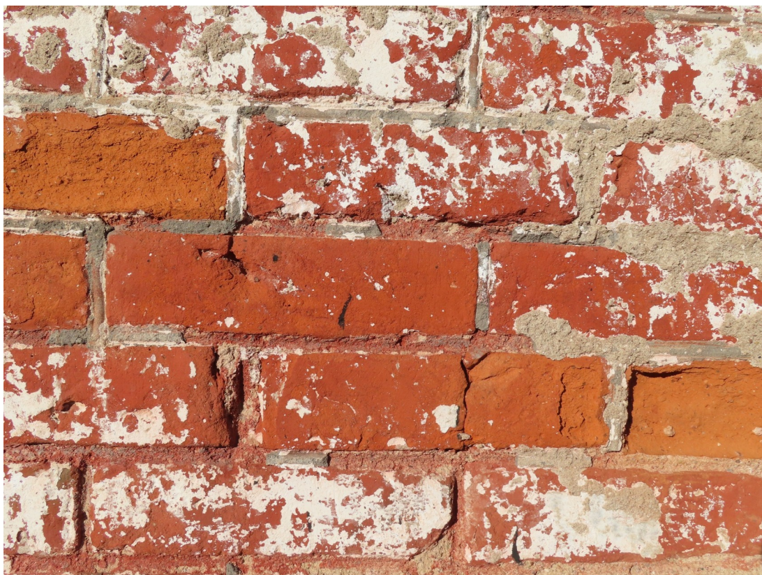
Pilskalna_5_88130010062001_fragments3 Dienvidaustrumu sienas fragments ar sākotnējo apdari – sarkani krāsotu ķieģeļu mūri, kas izšuvots ar tumši pelēku masā tonētu šuvi.
