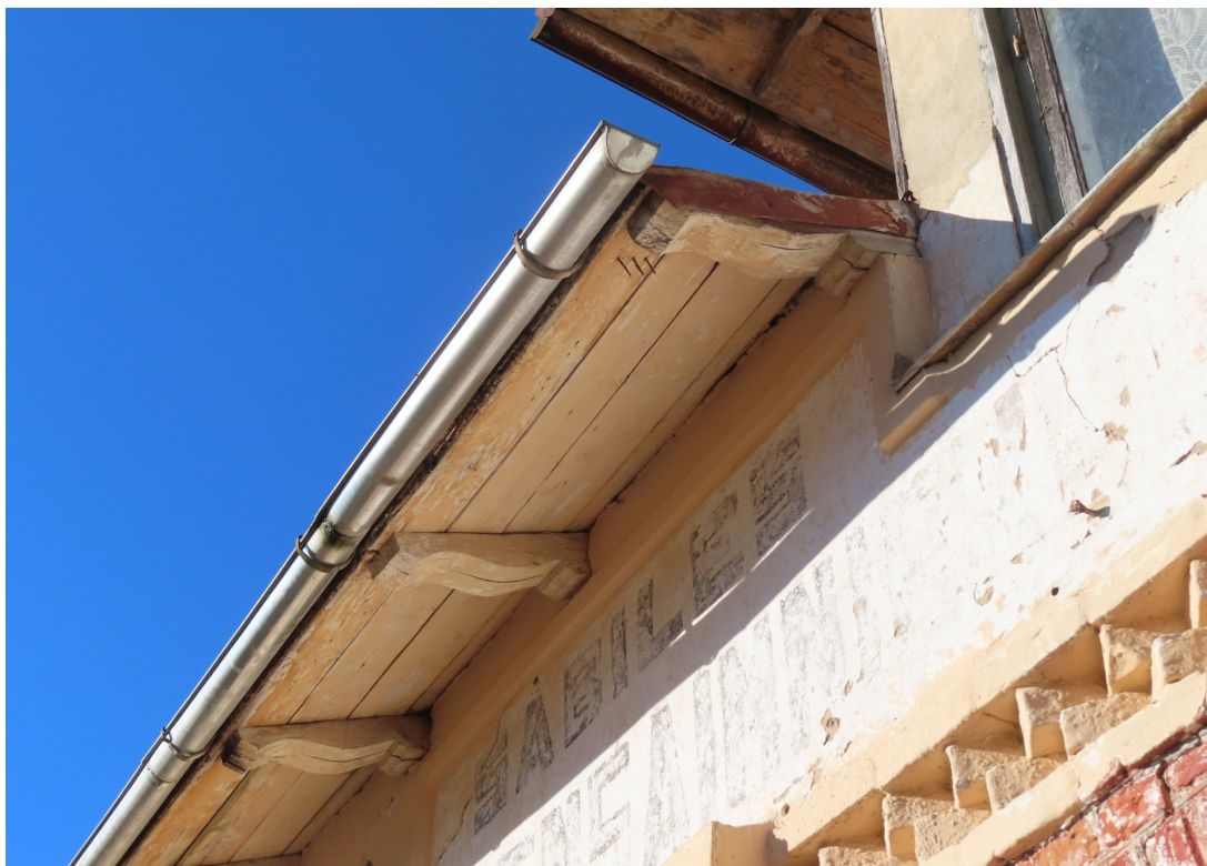
Pilskalna_5_88130010062001_fragments1 Skats uz sākotnējo ēkas jumta pārkari.
