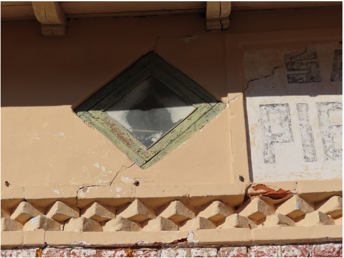
Pilskalna_5_88130010062001_logs1 Sākotnējs logs drempeļa līmenī.
