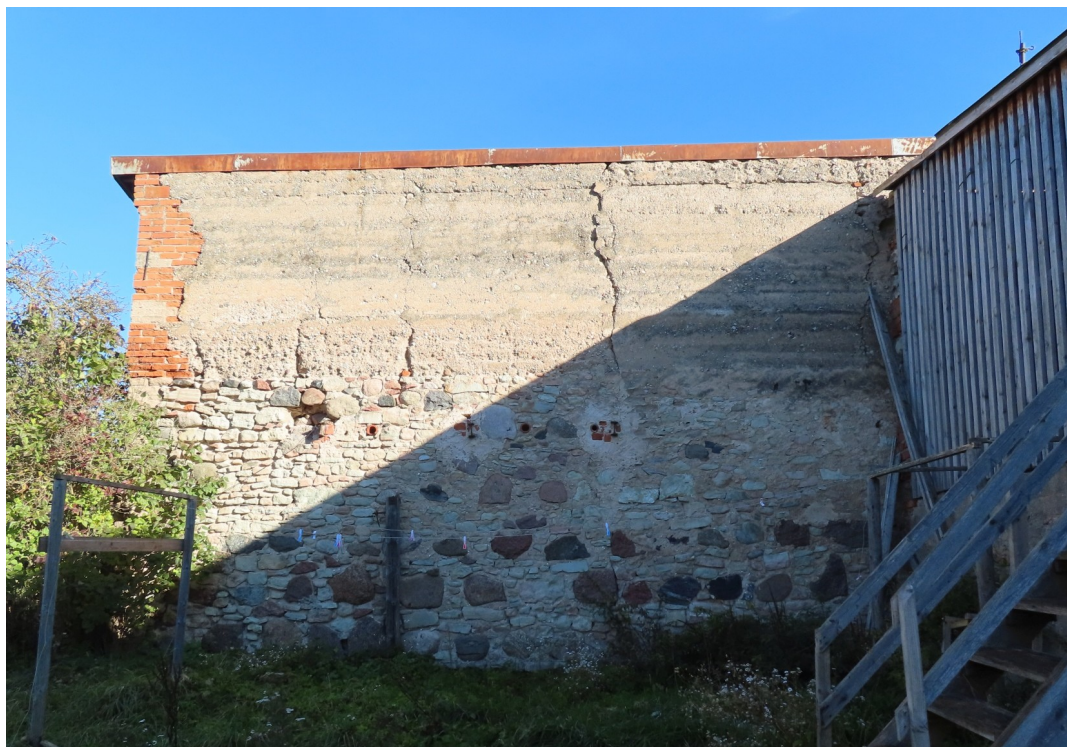
Pilskalna_3_88130010063002_fasade4 Skats uz ēku no dienvidrietumiem. 1.stāvs – 19.gs. beigas – 20.gs. sākums. Ēka paaugstināta 1920.-1930.gados (betonētā daļa).
