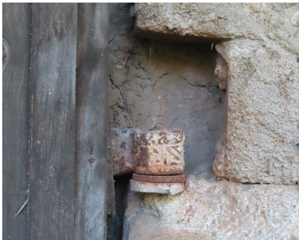
Pilskalna_3_88130010063002_durvis3 Atkārtoti izmantota vēsturiska lentveida kāša vira.
