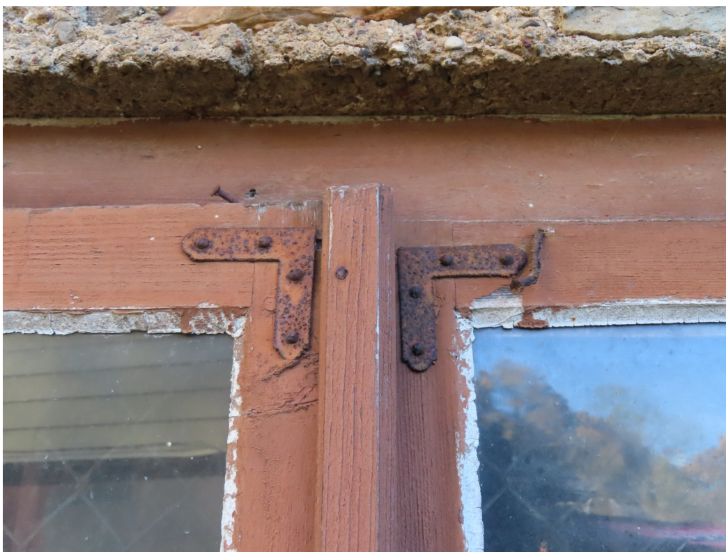
Pilskalna_3_88130010063002_logs3 Sākotnēji loga stūreņi. 19.gs. beigas – 20.gs. sākums.
