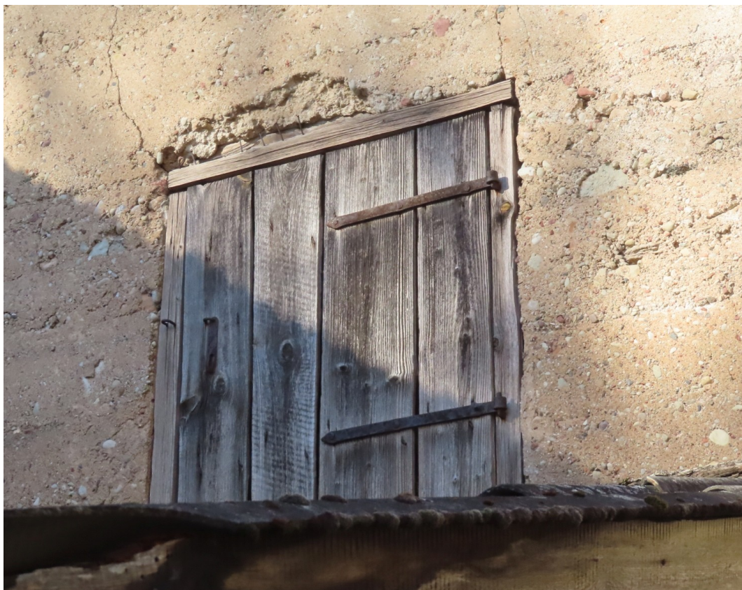
Pilskalna_3_88130010063002_durvis2 1920.- 1930.gadu slēģis ar aprīkojumu.
