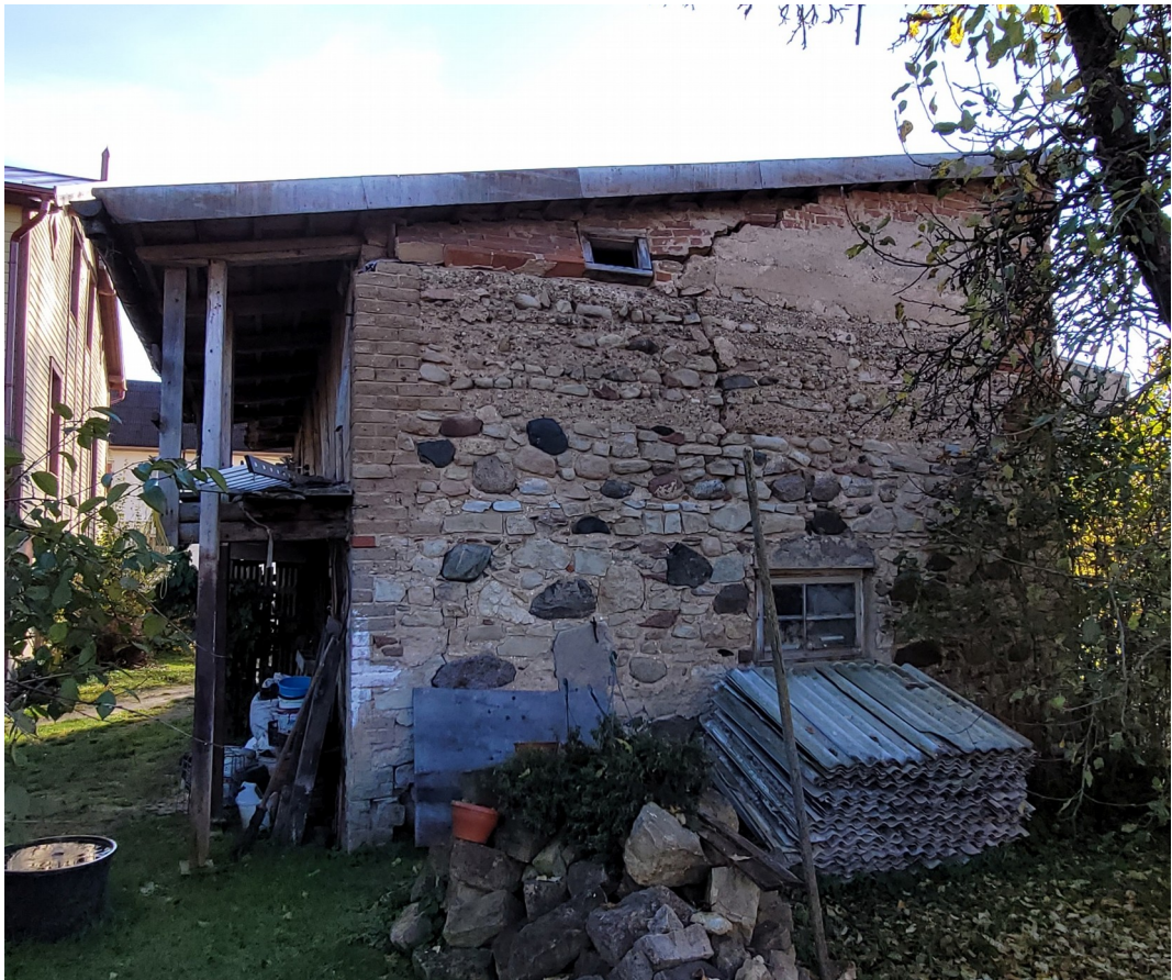
Pilskalna_3_88130010063002_fasade3 Skats uz ēku no ziemeļrietumiem.
