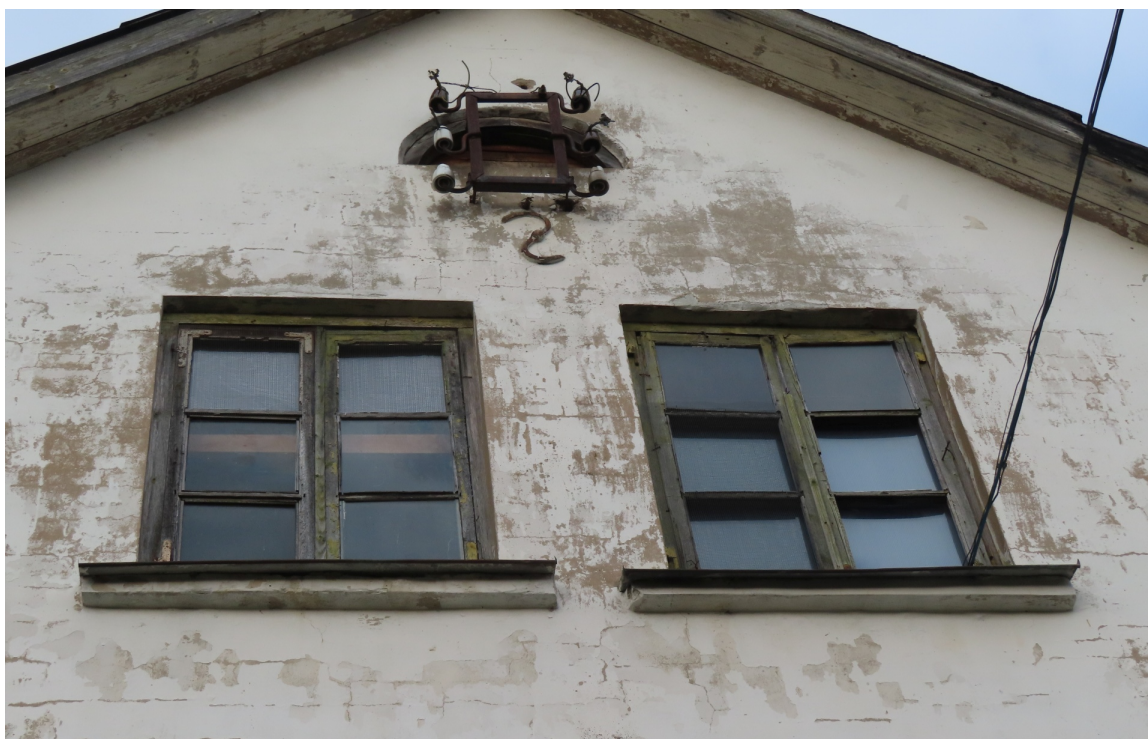
Kuldīgas_8_10_88130020151001_logs1 Vēsturiskie logi ar virām ēkas austrumu fasādes zelminī. 1915. - 1920./30.gadi.
