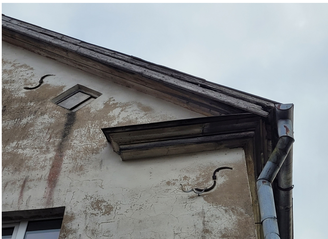
Kuldigas_8_10_88130020151001_dzega1 1915. - 1920./30.gadu koka dzega un metāla enkuri.
