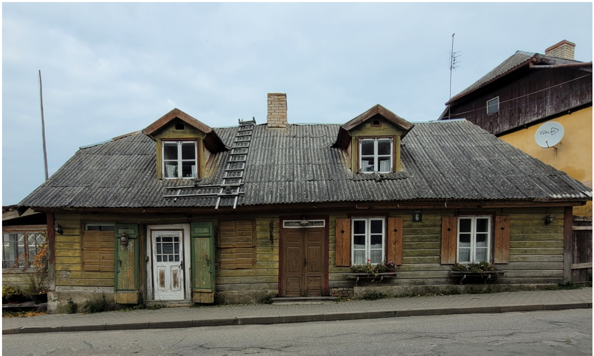
Kuldigas_6_88130020152001_fasade1 Skats uz ēku no dienvidiem. Fasādei 19. gs. beigu – 20.gs. sākuma apšuvums. Likvidēts nošļaupums jumta ziemeļaustrumu galā.
