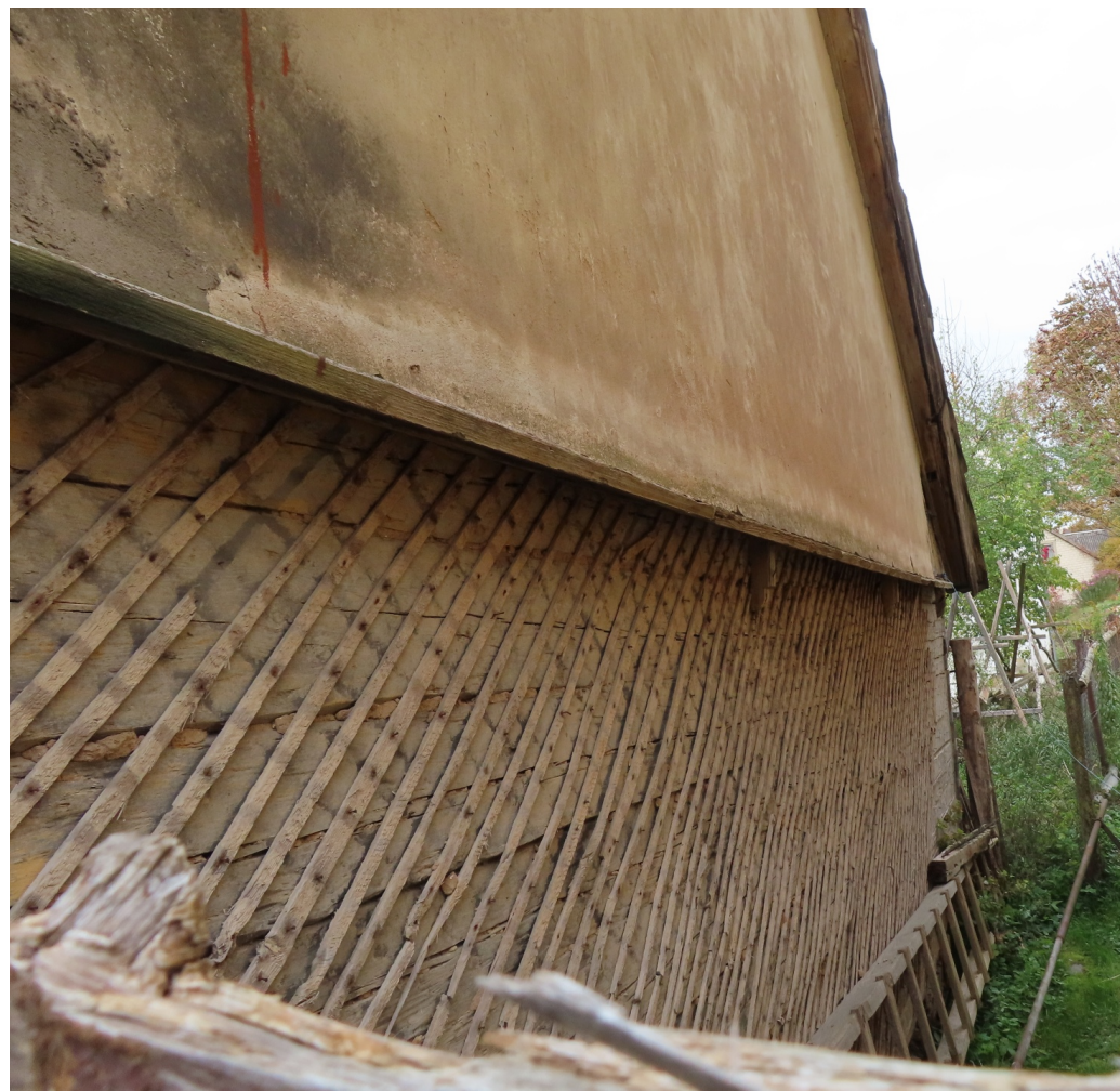
Kuldigas_6_88130020152001_fragments3 Skats uz austrumu fasādes fragmentu. 1.stāvā uz guļbaļķiem saglabājusies vēsturiskā apdare – krāsojums un 1920./30. gadu skali apmetumam.
