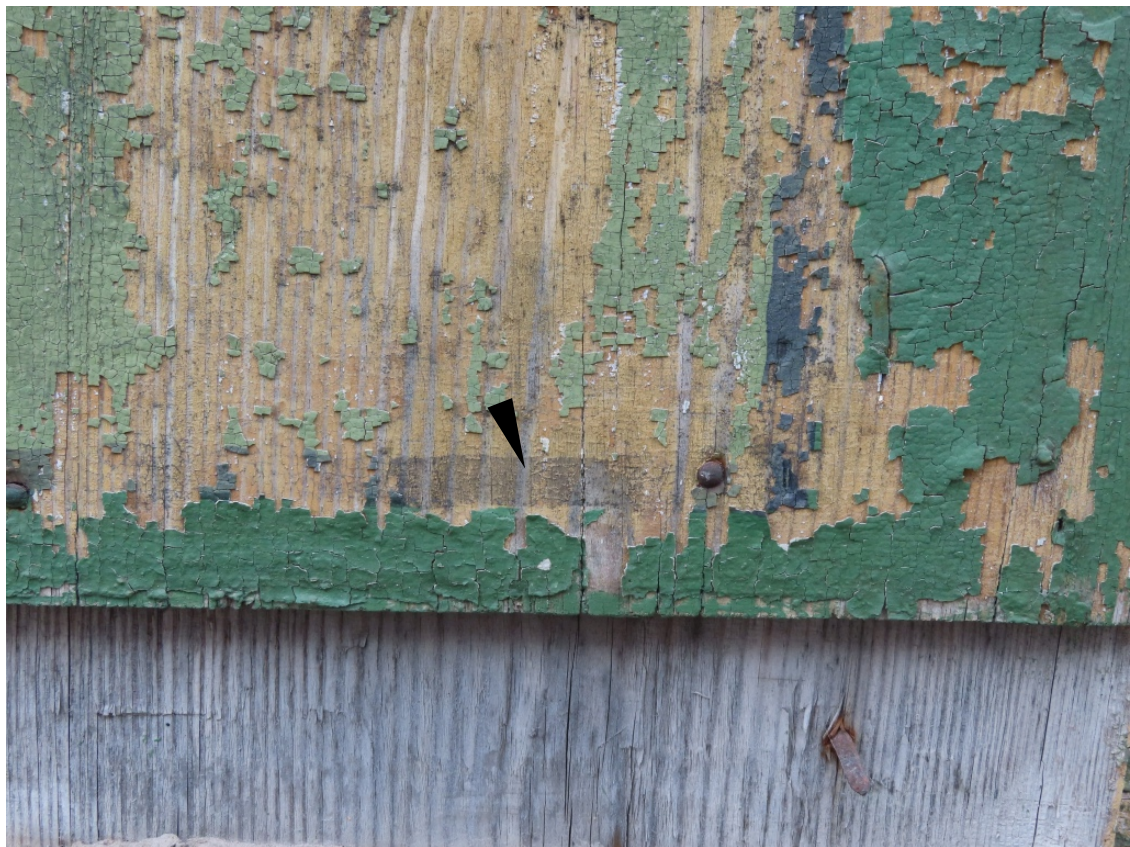
Kuldigas_6_88130020152001_durvis3 Durvju slēģa fragments ar vēsturiskiem krāsojuma slāņiem.
