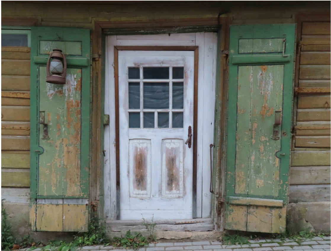
Kuldigas_6_88130020152001_durvis2 Durvju aila ar 19. gs. beigu – 20.gs. sākuma slēģiem un jaunu durvju vētrni. Slēģiem saglabājies aprīkojums un vēsturiskie apdares slāņi.
