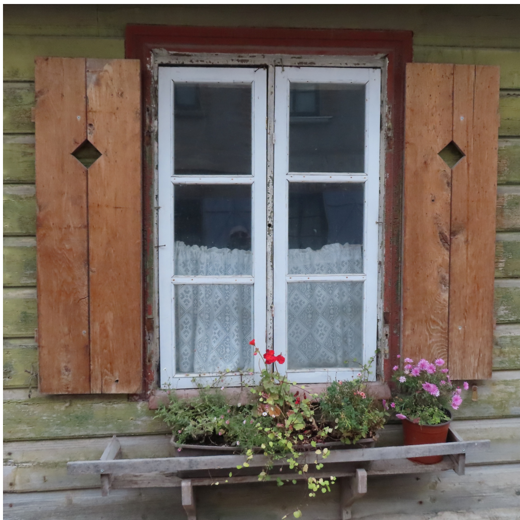
Kuldigas_6_88130020152001_logs2 Saglabājusies sākotnējā loga aploda. Vērtnes jaunas, atbilstošas. Koka vairogī – slēgu butaforija - neatbilstoši.
