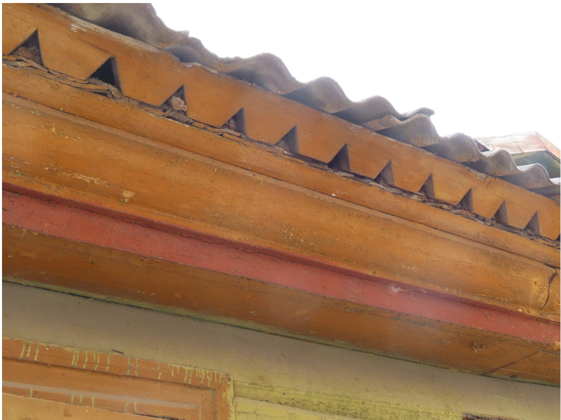
Kuldigas_6_88130020152001_fragments5 Sākotnēja dzega ar jaunu robdēli. Saglabājies skaidu zemsegums dakstiņu jumtam.
