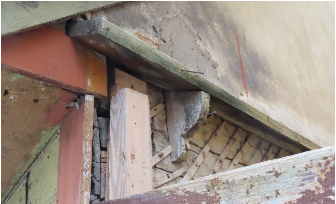
Kuldigas_6_88130020152001_fragments4 Ēkas austrumu fasādes fragments ar sākotnēju vai vēsturisku lietusdēļa konsoli.
