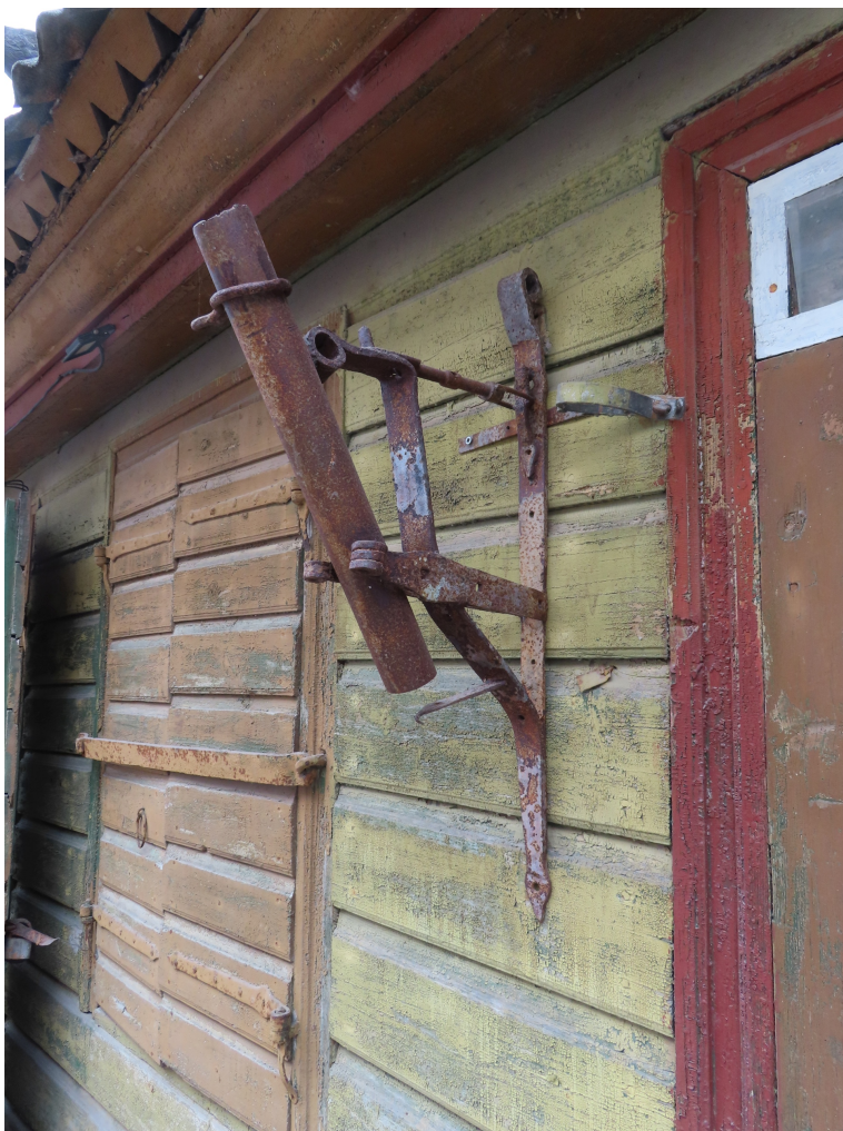
Kuldigas_6_88130020152001 _detala1 Jauns karoga k ta tur t js. Izmantotas v sturiskas lentveida k šu viras.
