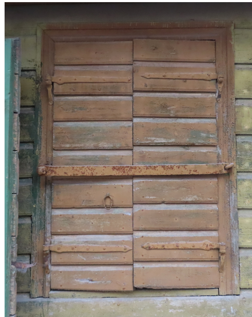
Kuldigas_6_88130020152001_slegis1 19. gs. beigu – 20.gs. sākuma slēģis ar aprīkojumu.
