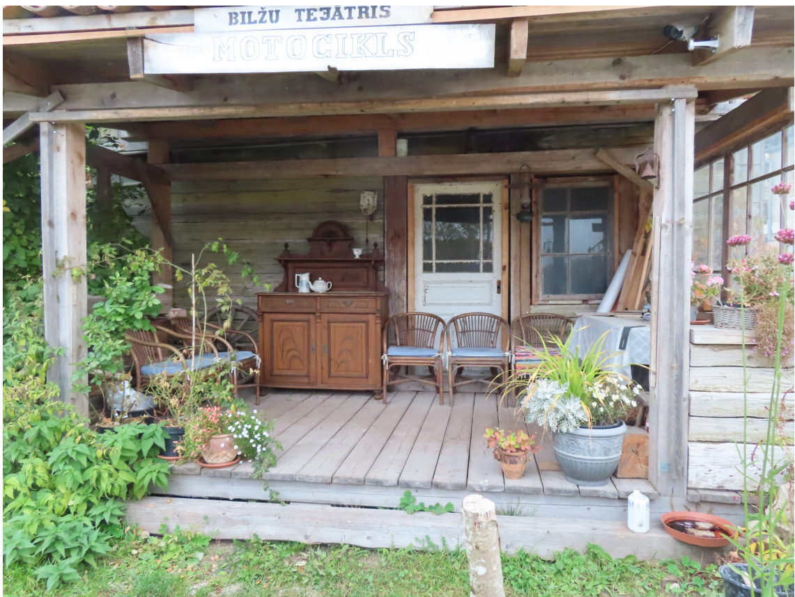
Kuldigas_6_88130020152001_fragments1 Skats uz rietumu fasādes fragmentu aiz jaunās piebūves. Saglabājušies guļbaļķi bez apšuvuma.
