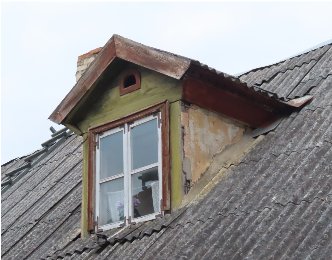
Kuldīgas_6_88130020152001_fragments6 Vēsturiska jumta loga izbūve (19. gs. beigas – 20.gs. sākums) ar oriģinālo logu.
