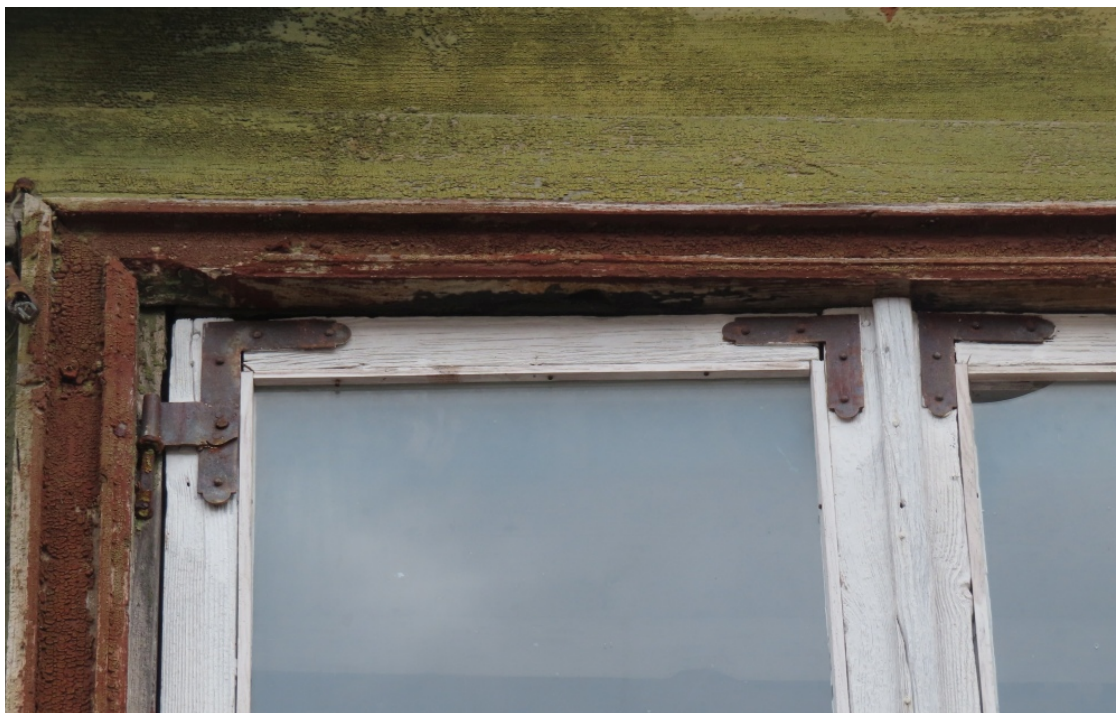
Kuldīgas_6_88130020152001_logs1 19. gs. beigu – 20.gs. sākuma vira un stūreņi.
