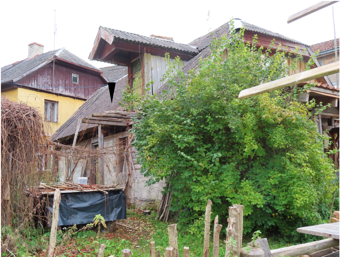
Kuldigas_6_88130020152001_fasade5 Skats uz ēku no rietumiem. Vēsturiska jumta izbūve, zem kuras atradusies nezināmas funkcijas konstrukcija (?).
