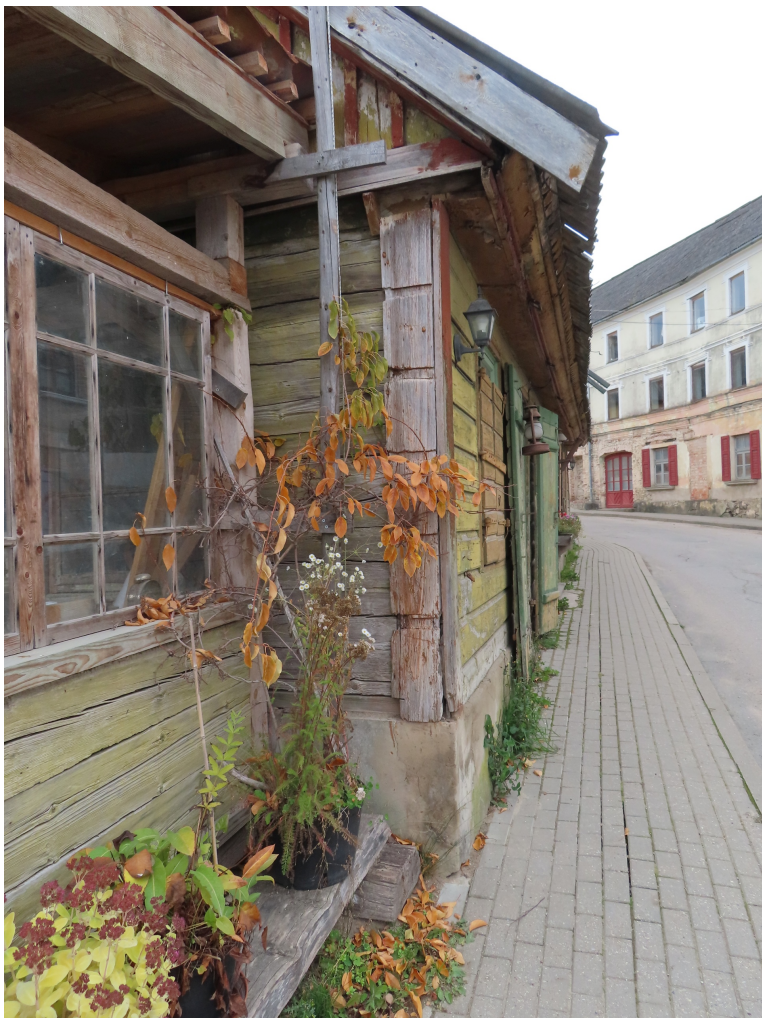
Kuldigas_6_88130020152001_fragments2 Saglabājusies sākotnējā lizēna ar rustu dalījumu.
