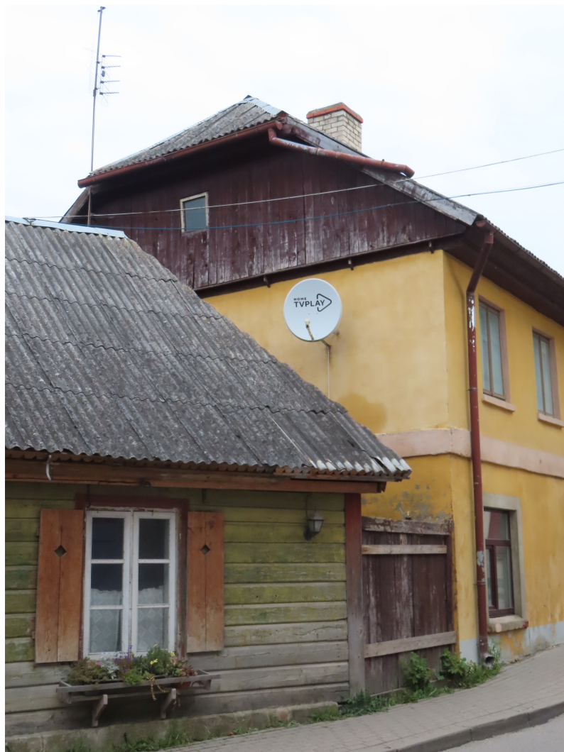
Kuldigas_4_88130020149001_fasade5 Skats uz ēku no dienvidiem.
