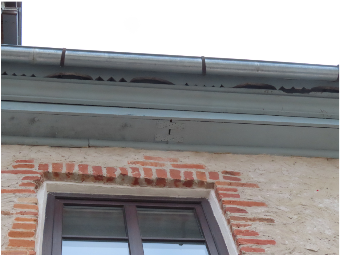
Kuldigas_3_88130040002001_dzega1 Sākotnēja dzega, remontēta. Saglabājies robdēlis.
