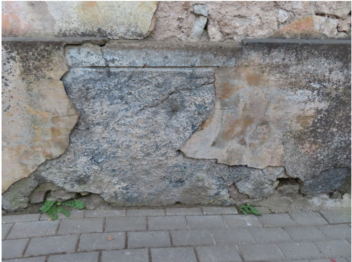
Kuldigas_1_88130040043001_fragments3 Ziemeļrietumu fasādes fragments ar 19.gs.2.puses – ~1890.g. cokola apmetumu.
