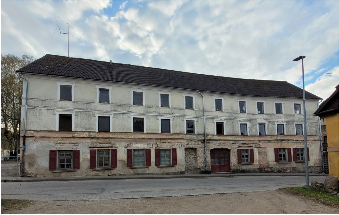
Kuldigas_1_88130040043001_fasade1 Skats uz ēku no ziemeļrietumiem. 1.stāvā mainīts ailojums, nokalts reljefais dekors.
