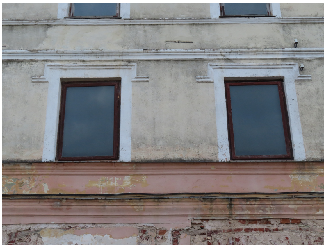
Kuldigas_1_88130040043001_fragments2 Ziemeļrietumu fasādes fragments ar 19.gs.2.puses – ~1890.g. reljefo apdari.
