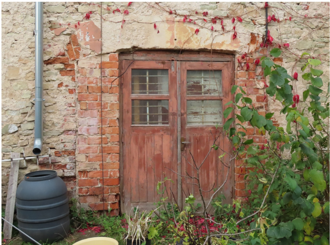
Kuldigas_1_88130040043001_fragments4 Dienvidaustrumu (pagalma) fasādes fragments – 1960.- 1970.gados aizbūvēta caurbrauktuve un izveidota esošā durvju aila.
