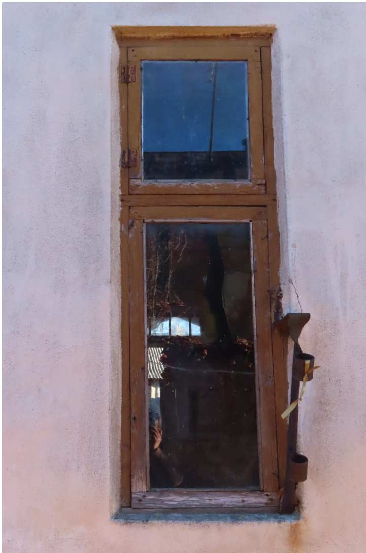
Kalna_2_88130040013001_slegis3 Sākotnējs slēģa aizvērta stāvokļa fiksators.
