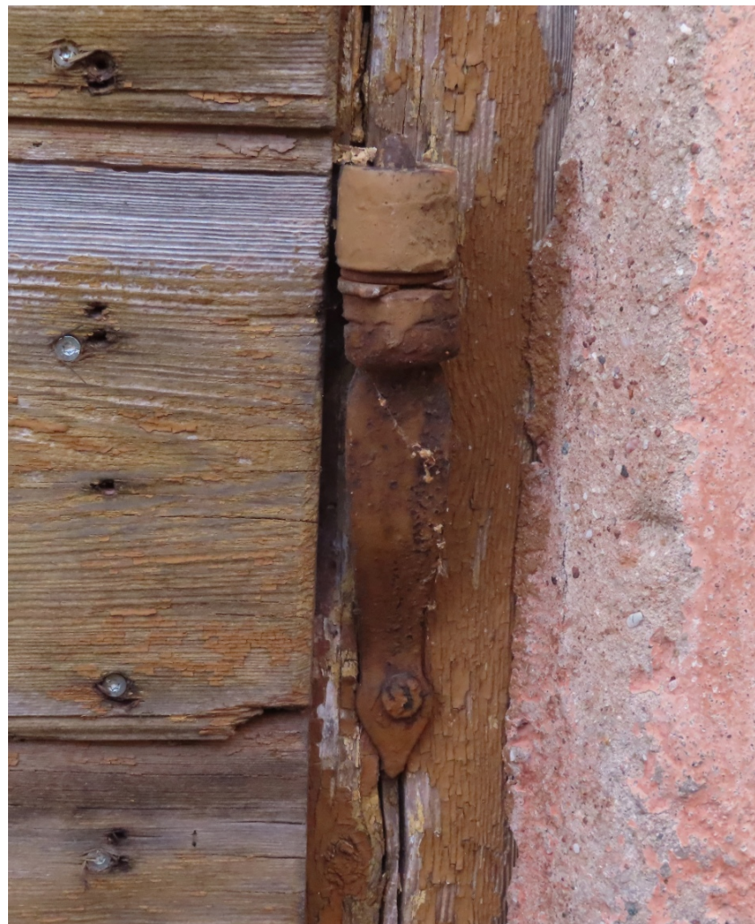
Kalna_2_88130040013001_durvis8 Pagraba durvju oriģinālais viru kāsis.
