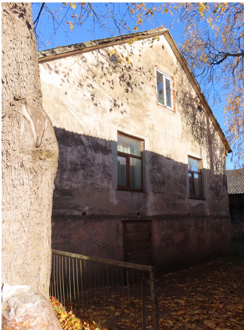
Kalna_2_88130040013001_fasade5 Ēkas dienvidrietumu fasāde.
