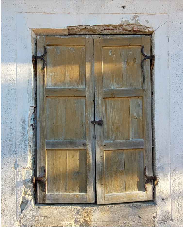
Kalna_2_88130040013001_ slegis1 Sākotnējs slēģis ar aprikojumu.
