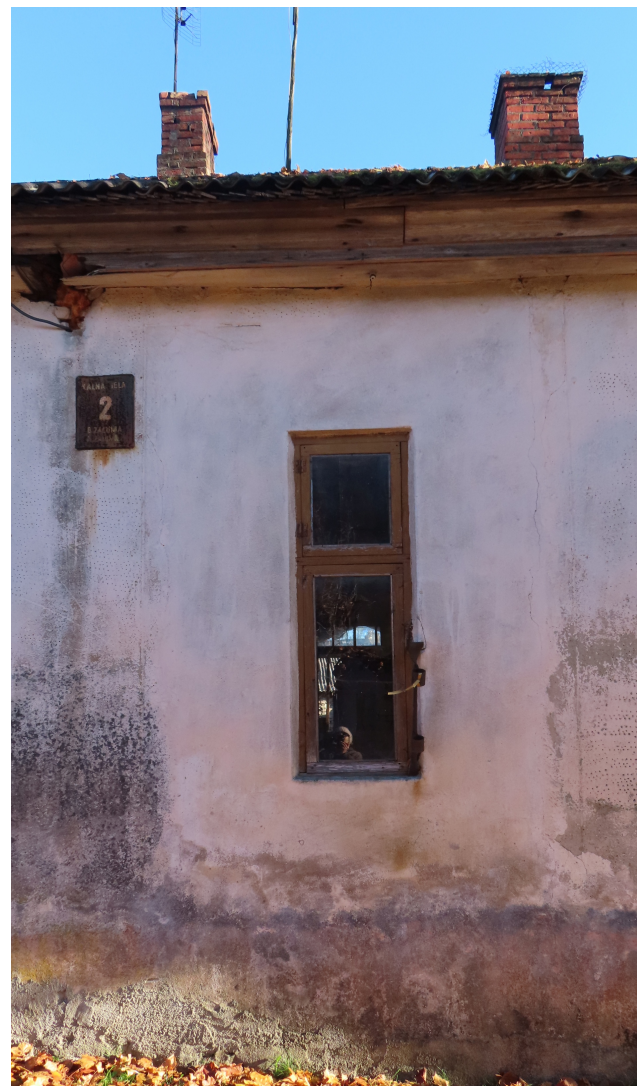
Kalna_2_88130040013001_fragments1 Ēkas ziemeļrietumu fasādes vidusdaļas fragments. Saglabājusies sākotnējā dēļu dzega. Vēsturisks logs sākotnējās ieejas vietā. Saglabājušās apmetumā ievilkto durvju apmaļu kontūras.
