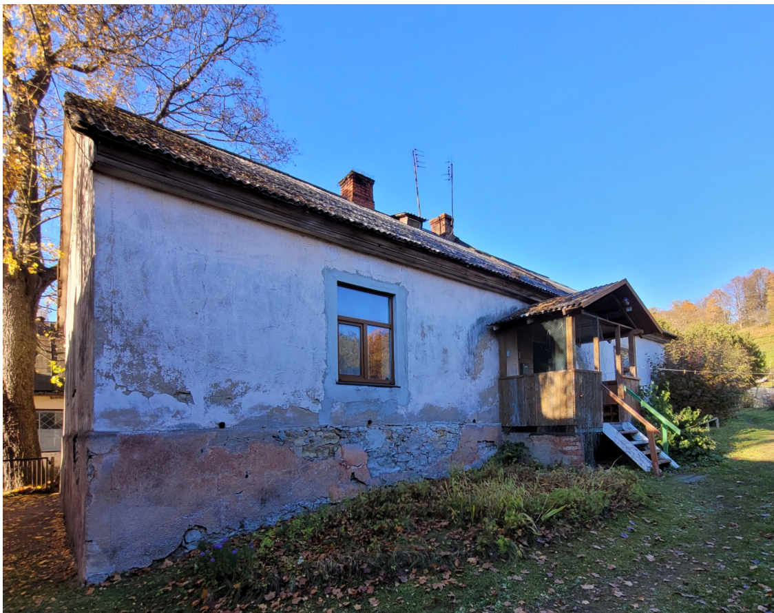
Kalna_2_88130040013001_fasade3 Ēkas dienvidaustrumu fasāde. Ieejas lievenis – 20.gs.beigas uz vēsturiskiem pamatiem.
