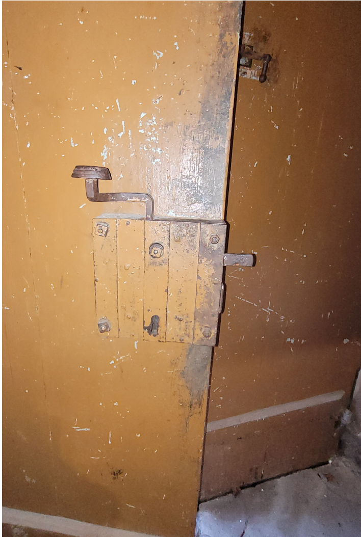
Kalna_2_88130040013001_durvis5 Sākotnēja kastes slēdzene.
