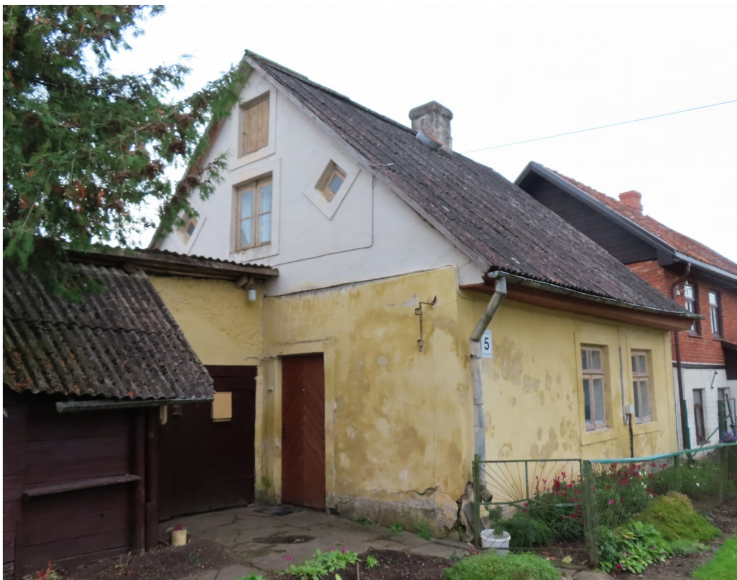
Avotu_5_88130020012001_fasade1 Skats uz ēku no ziemeļiem.
