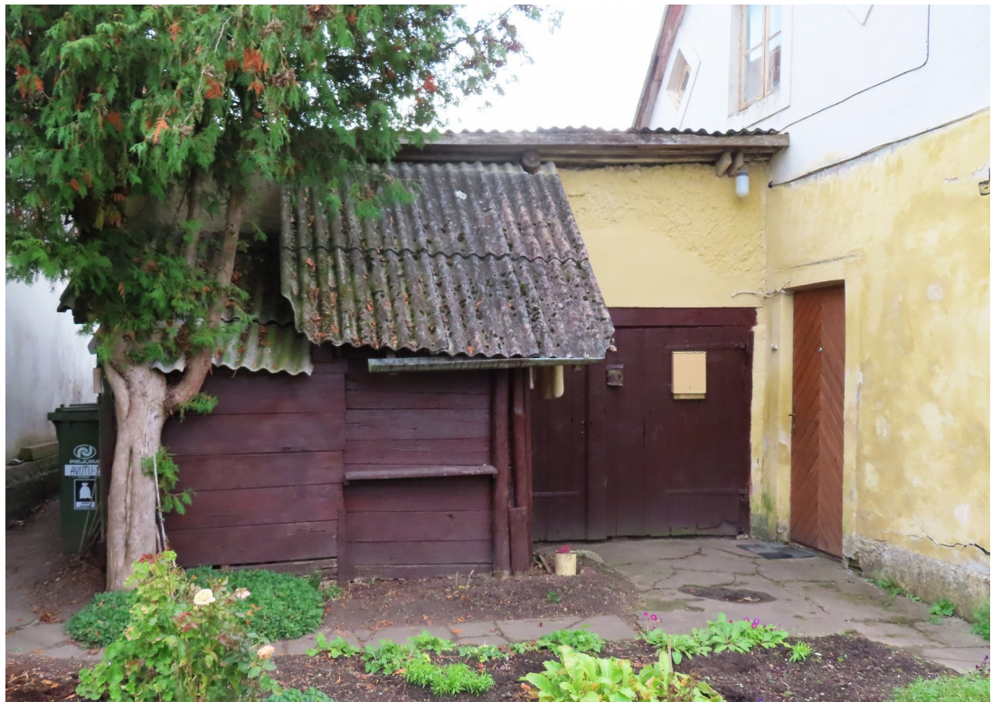
Avotu_5_88130020012001_fasade4 Skats uz ēkas piebūvi (aizmugurējā plānā) no ziemeļrietumiem. Priekšplāna koka piebūve - bez kadastra apzīmējuma - 20.gs. beigas.
