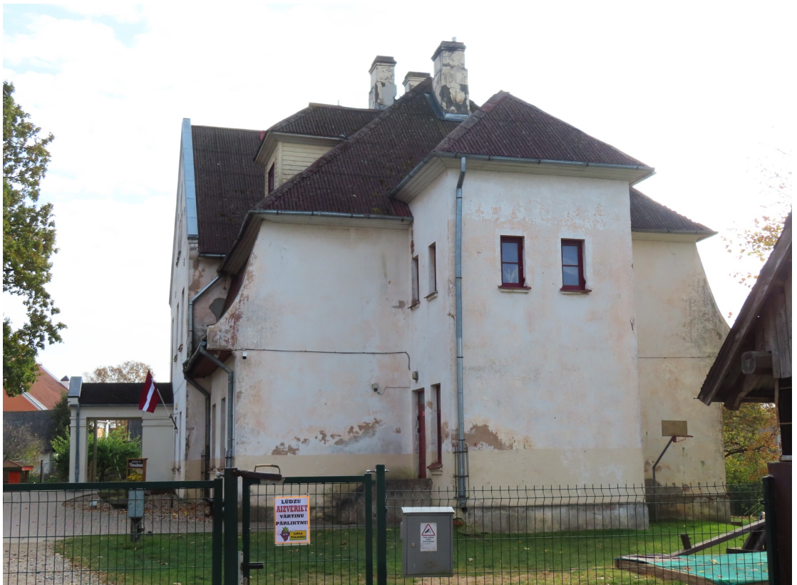
Abavas_5_88130020126001_fasade2 Skats uz ēku no ziemeļrietumiem.
