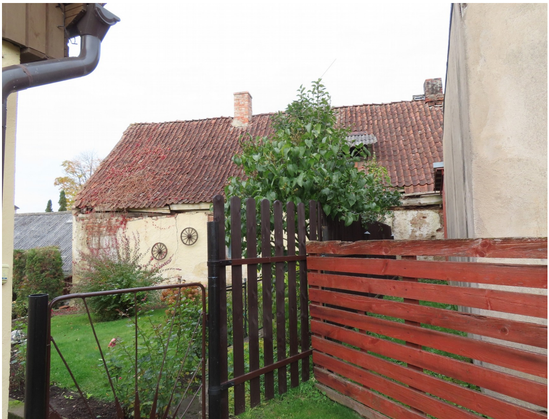
Abavas_3_88130020015001_002_fasade6 Skats uz ēku no dienvidaustrumiem. Pagalma fasādes dienvidrietumu gals.
