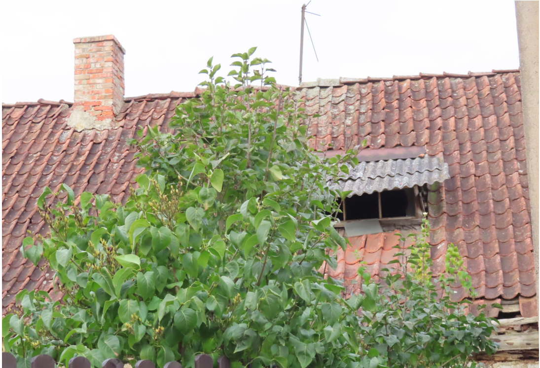
Abavas_3_88130020015001_002_logs3 1910.gada pulsts tipa jumta loga izbūve.
