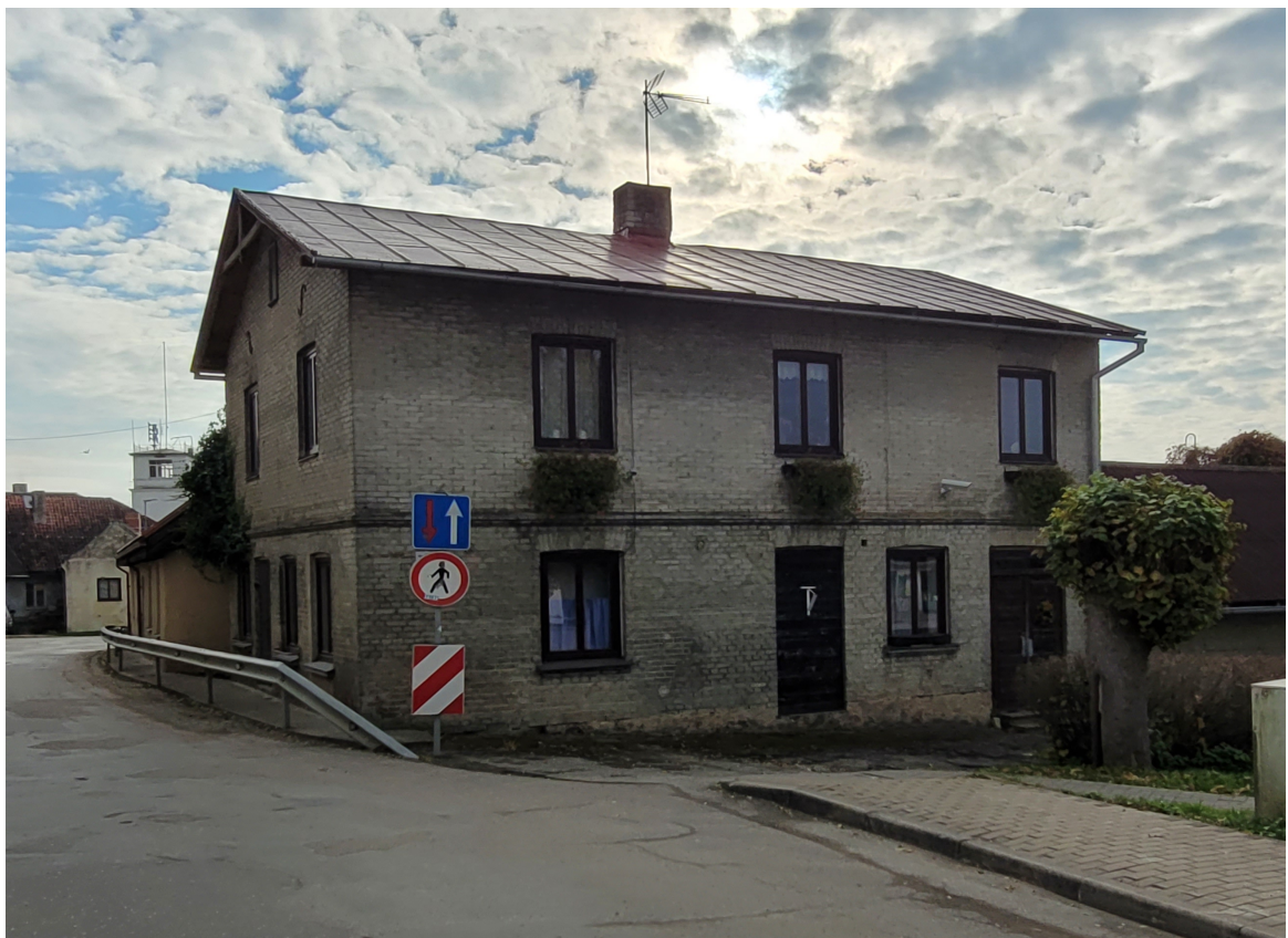
Abavas_1_88130020016005_fasade2 Skats uz ēku no ziemeļrietumiem. Durvju aila fasādes centrā aizšūta 20.gs.2.pusē.
