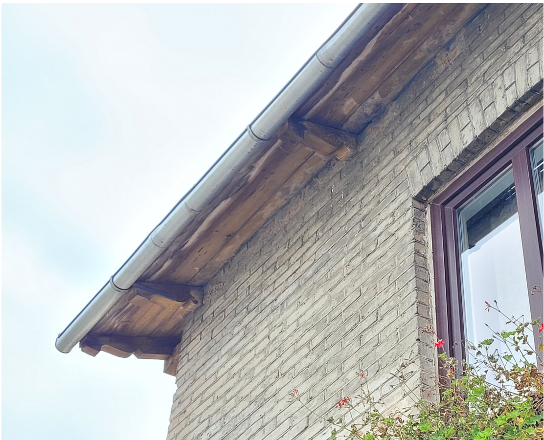
Abavas_1_88130020016005_fragments2 Sākotnējās spāres ziemeļrietumu fasādē.
