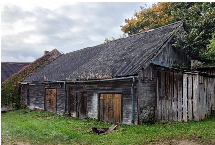
Talsu_1_7_88130010053003 _fasade1 Skats uz ēku no austrumiem.
