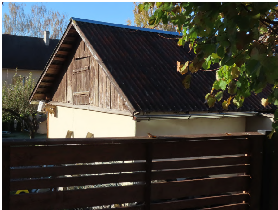
Pilskalna_8_88130040007002_ fasade1 Skats uz ēku no austrumiem.
