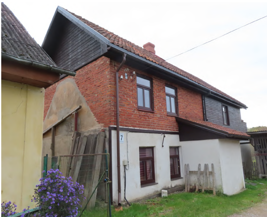
Avotu_7_88130020134001 _fasade1 Skats uz ēku no ziemeļiem.
