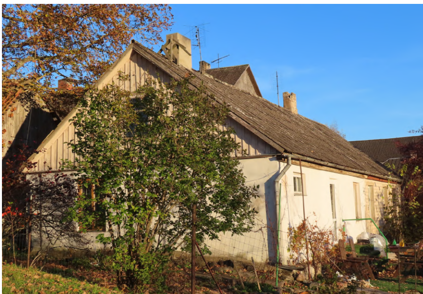
Riigas_4_6A_88130020010001 _fasade1 Skats uz ēku no rietumiem.
