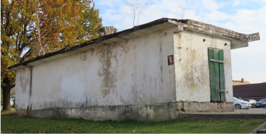
Ventspils_9_88130020125001 _fasade2 Skats uz ēku no rietumiem.
