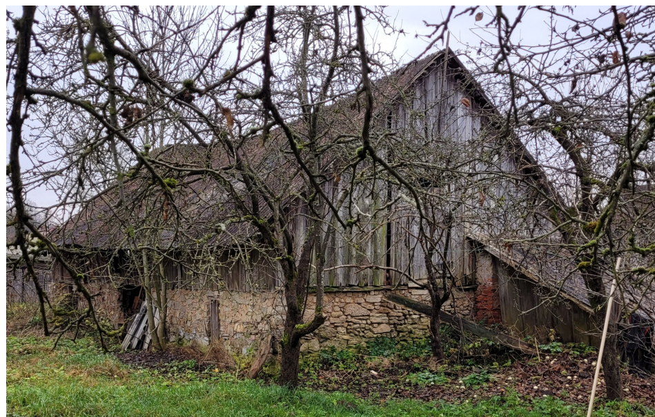
Riigas_23_88130040015003_fasade2 Skats uz ēku no ziemeļiem.
