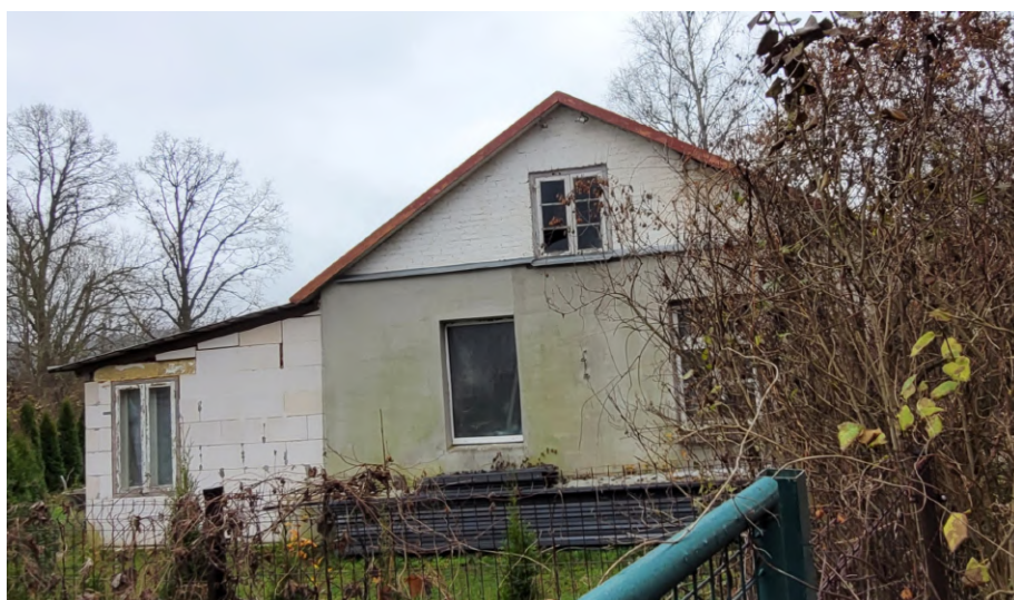
Riigas_32A_88130040037001 _fasade2 Skats uz ēku no ziemeļaustrumiem.
