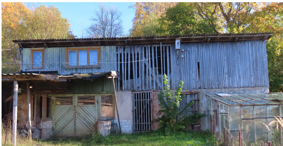
Pilskalna_12_881300400590021 _fasade1 Skats uz ēku no dienvidrietumiem.
