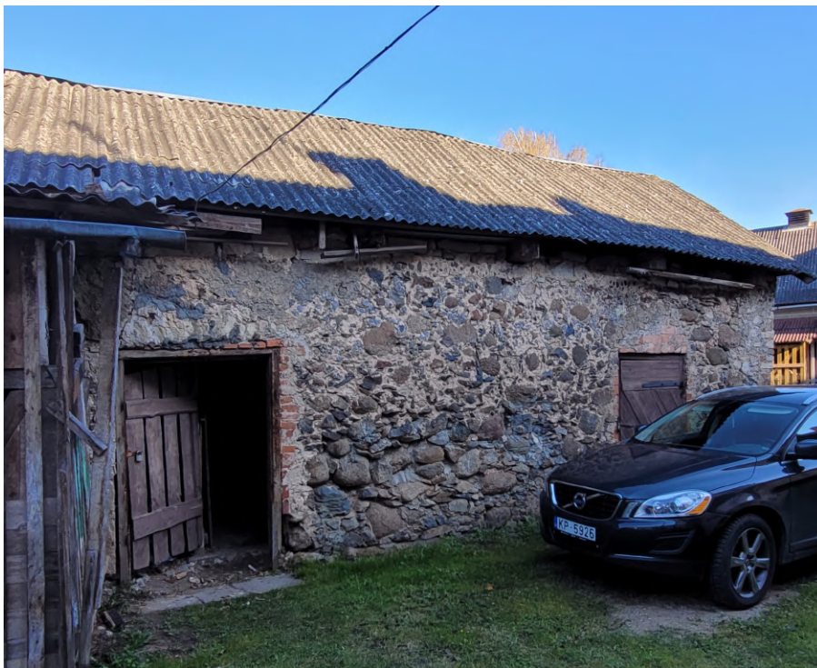
Riigas_9_88130010003005_ fasade2 Skats uz ēku no rietumiem.
