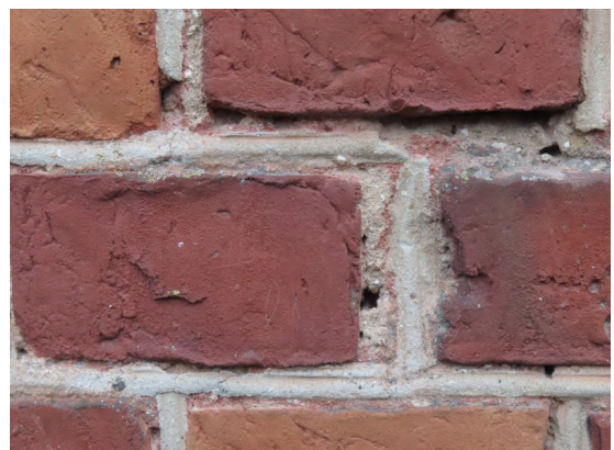
Riigas_32_88130040067001_fragments1 Fasādes fragments ar sākotnējo apdari – krāsojumu uz ķieģeļiem. Krāsojums saglabājies zem šuvojuma.
