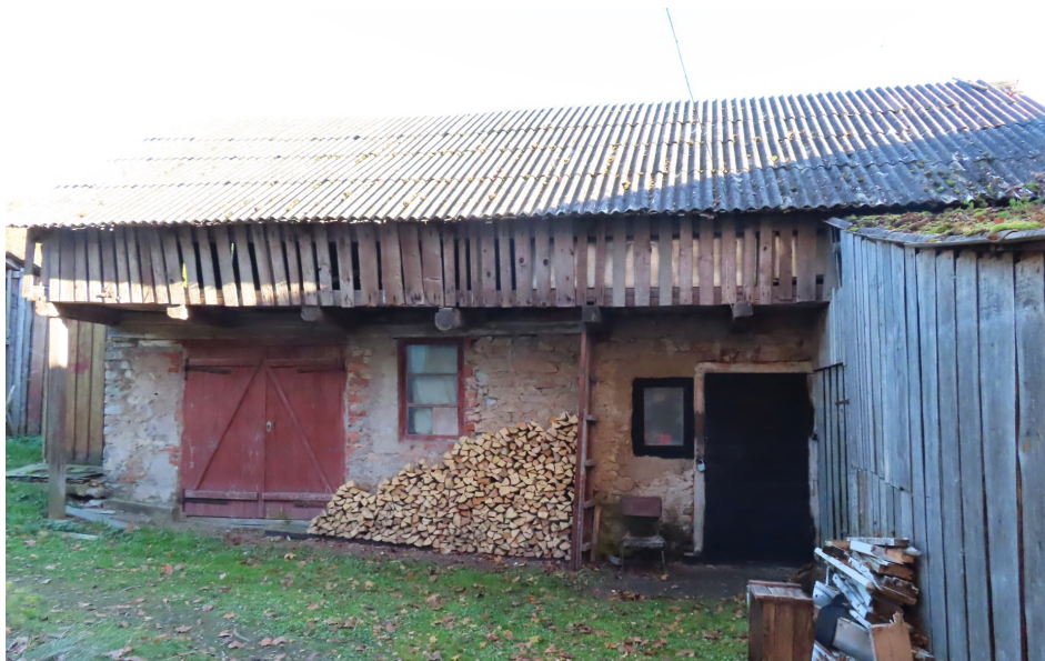
Kalna_2_88130040013003_ fasade1 Skats uz ēku no ziemeļrietumiem.
