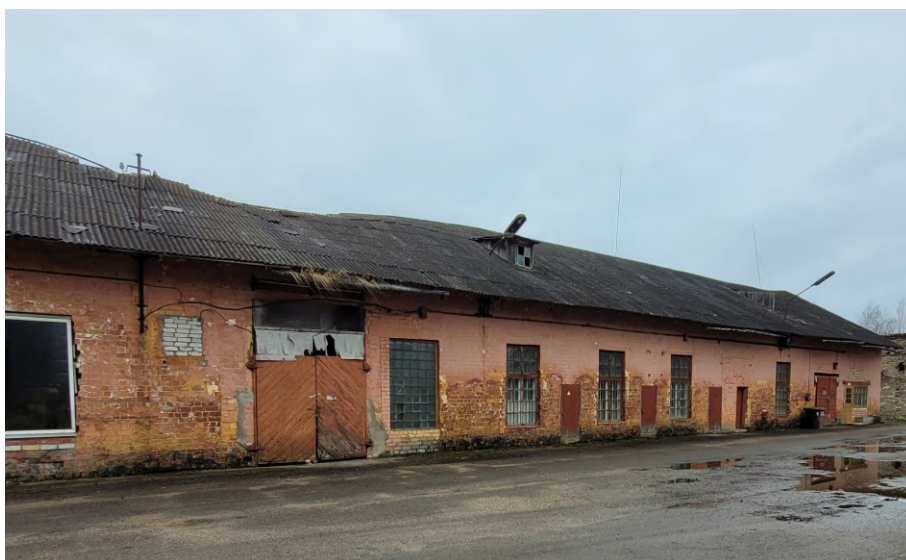
Riigas_22_88130040068001_ fasade3 Skats uz ēku no ziemeļaustrumiem. 20.gs. vidus.
