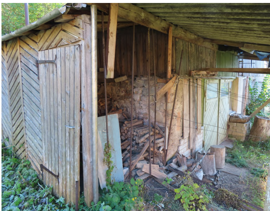
Pilskalna_12_881300400590021 _fasade2 Skats uz ēku no ziemeļrietumiem.
