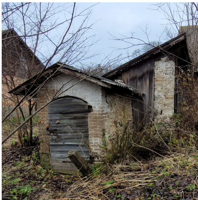
Riigas_23_88130040015002_fasade1 Skats uz ēku no dienvidiem.
