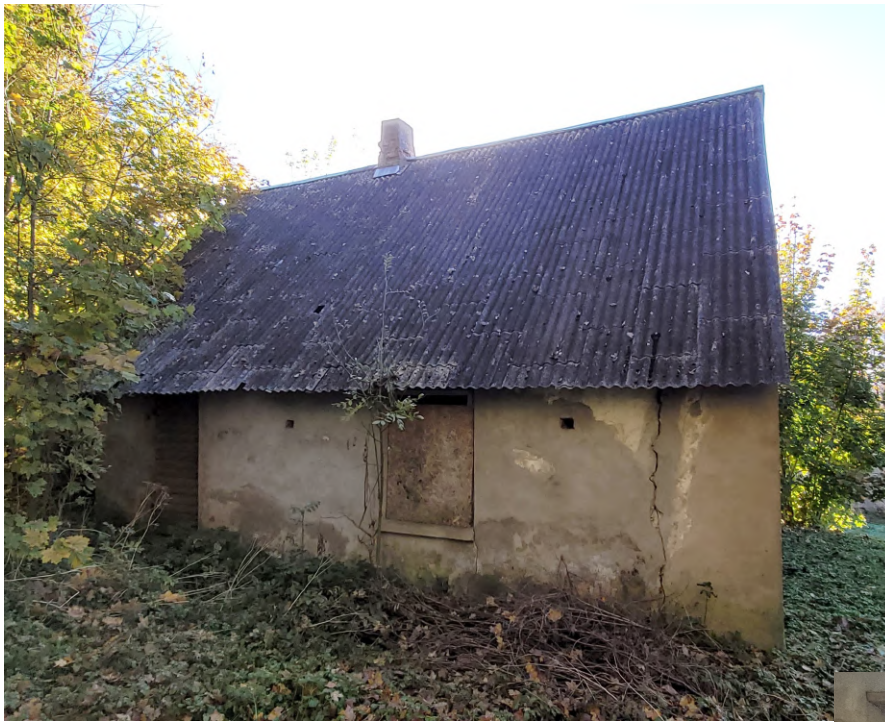
Pilskalna_14_88130040008001 _fasade1 Skats uz ēku no ziemeļrietumiem.
