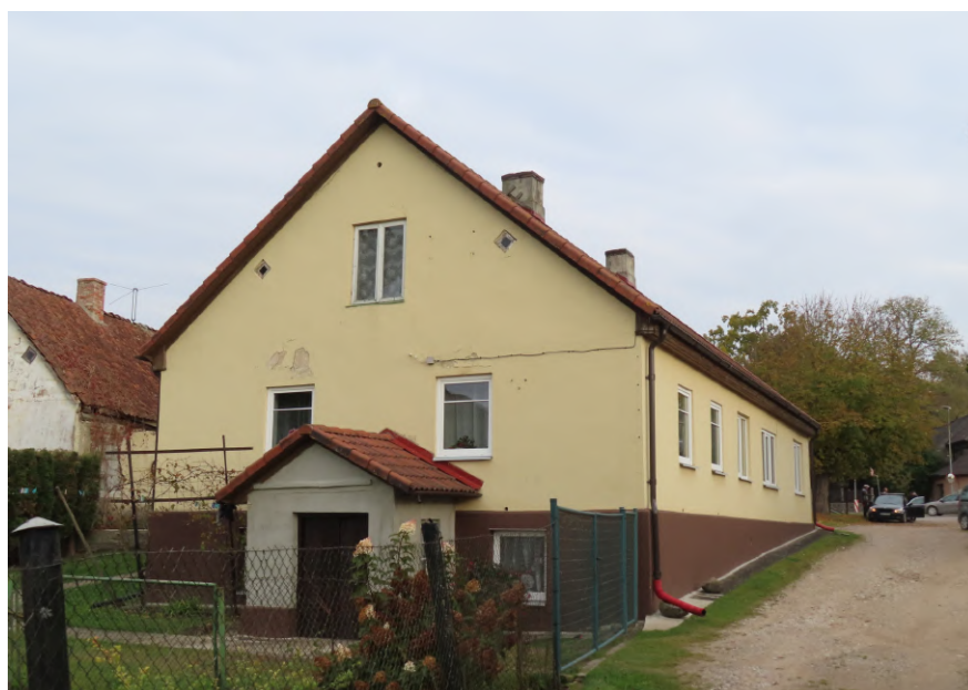
Avotu_4_88130020014001_ fasade1 Skats uz ēku no dienvidrietumiem.
