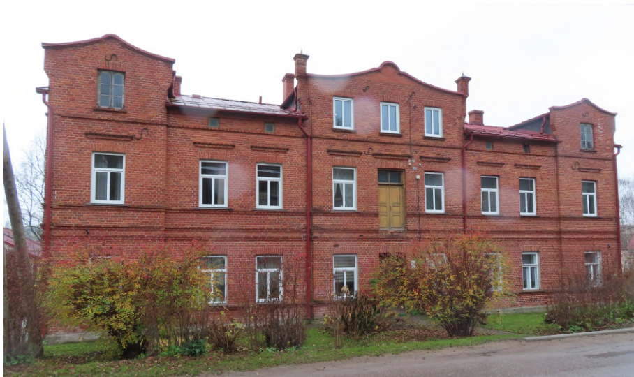
Riigas_32_88130040067001_ fasade1 Skats uz ēku no ziemeļaustrumiem.
