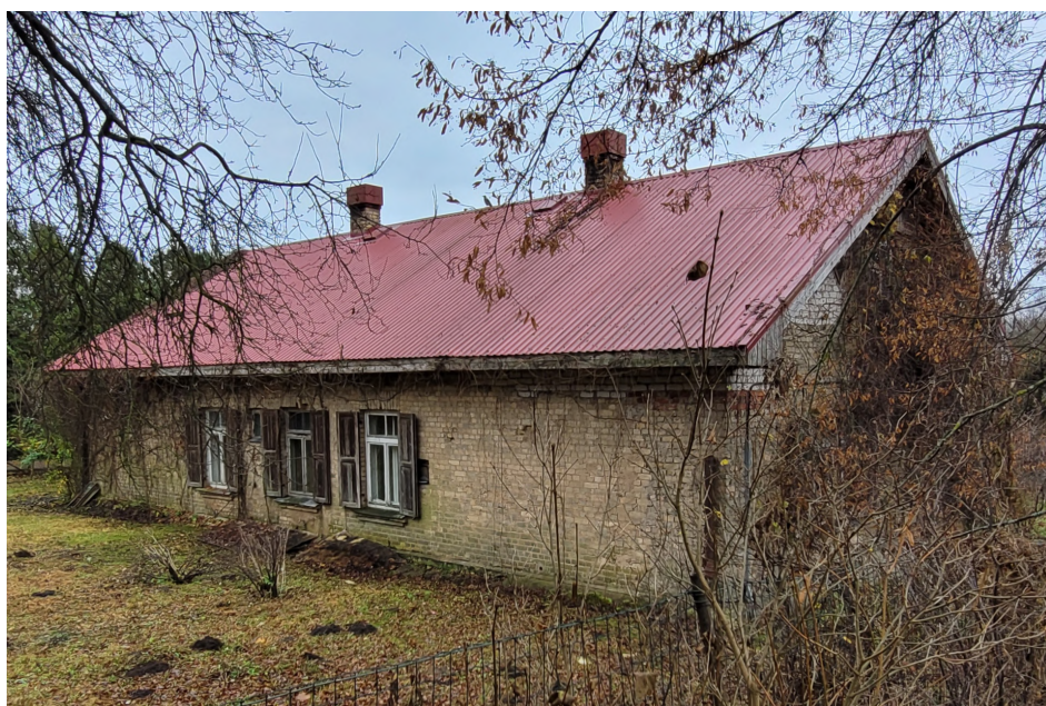
Riigas_13_88130040012003 _fasade1 Skats uz ēku no ziemeļiem.
