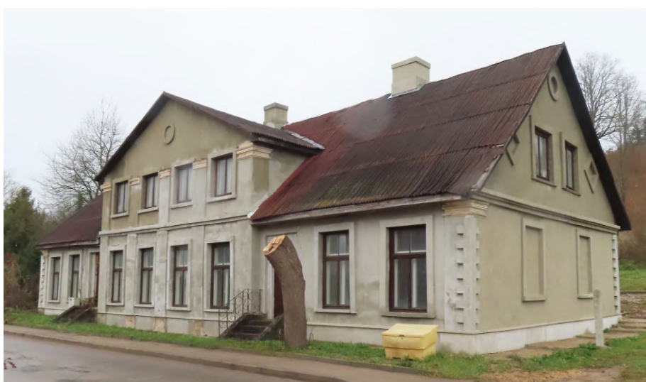
Riigas_35_88130040064001_ fasade1 Skats uz ēku no dienvidiem.
