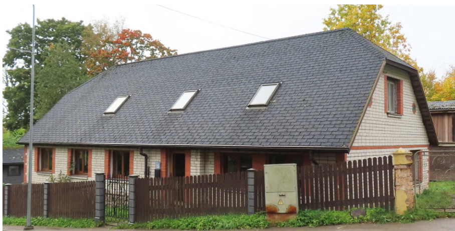
Talsu_15_8813001005500_ fasade1 Skats uz ēku no austrumiem. Būtiski pārbūvēta 19.gs. 2.puses (vidus ?) ēka
