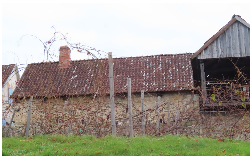
Avotu_6_88130020013002 _fasade2 Skats uz ēku no dienvidrietumiem.
