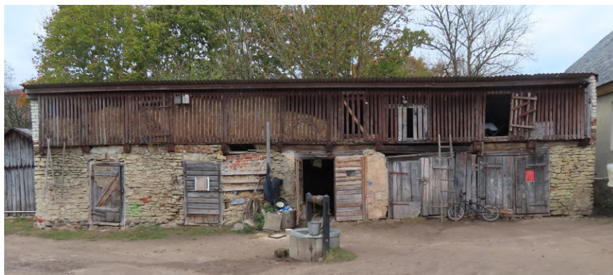
Ventspils_15_17_88130020129 004_fasade1 Skats uz ēku no dienvidaustrumiem.
