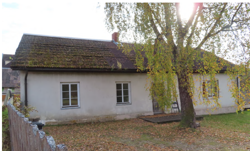
Abavas_8_88130020017001 _fasade1 Skats uz ēku no ziemeļrietumiem.
