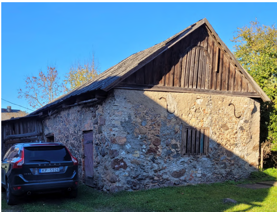
Riigas_9_88130010003005_ fasade3 Skats uz ēku no dienvidiem.
