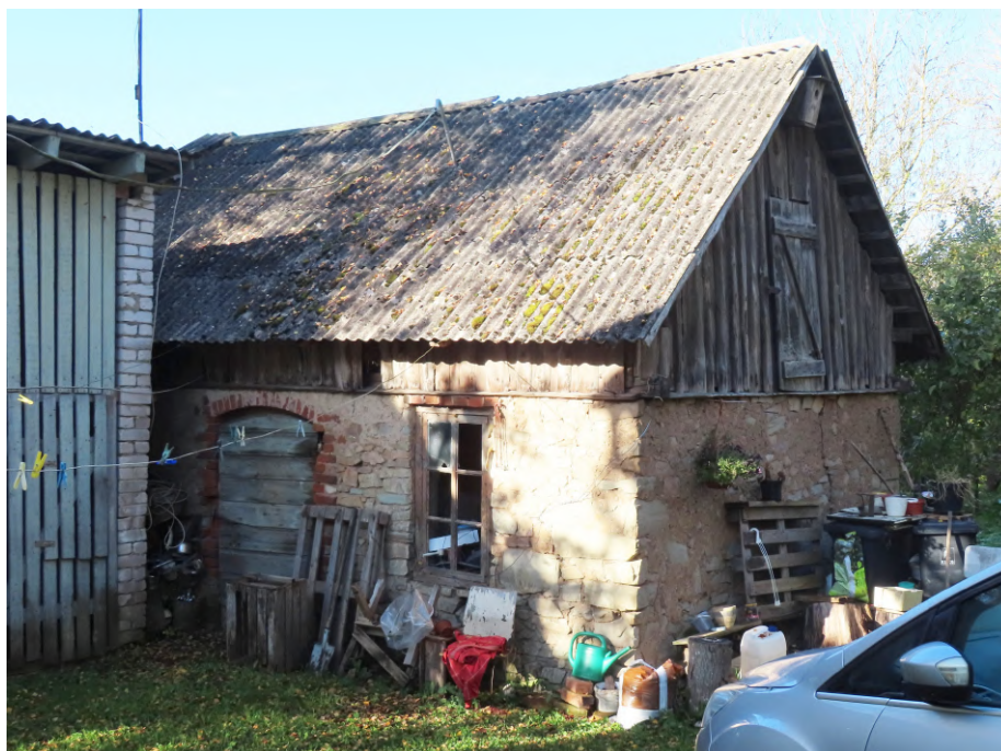
Pilskalna_7_88130010061003_ fasade1 Skats uz ēku no dienvidaustrumiem.
