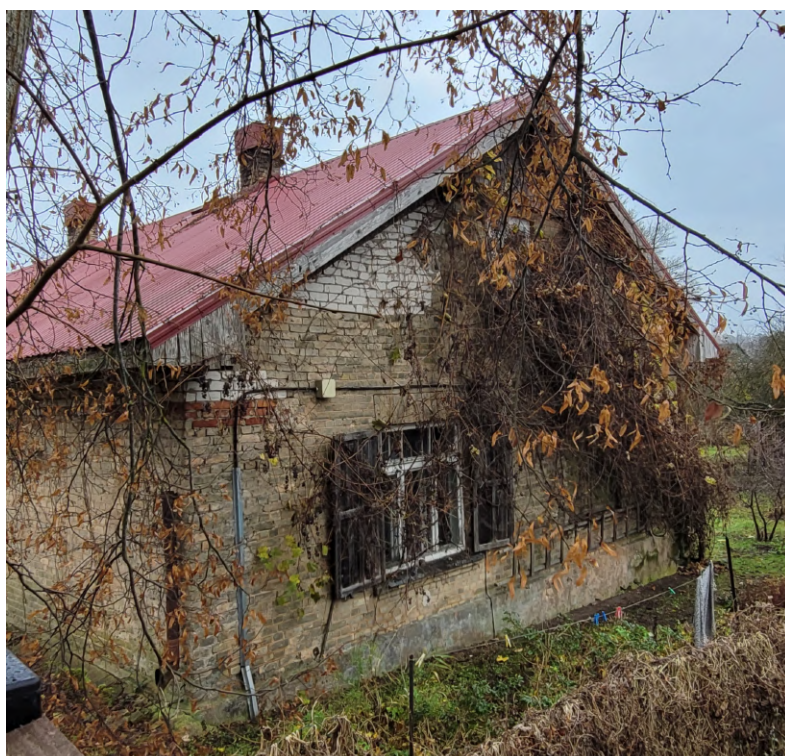
Riigas_13_88130040012003_fasade2 Skats uz ēku no ziemeļrietumiem.
