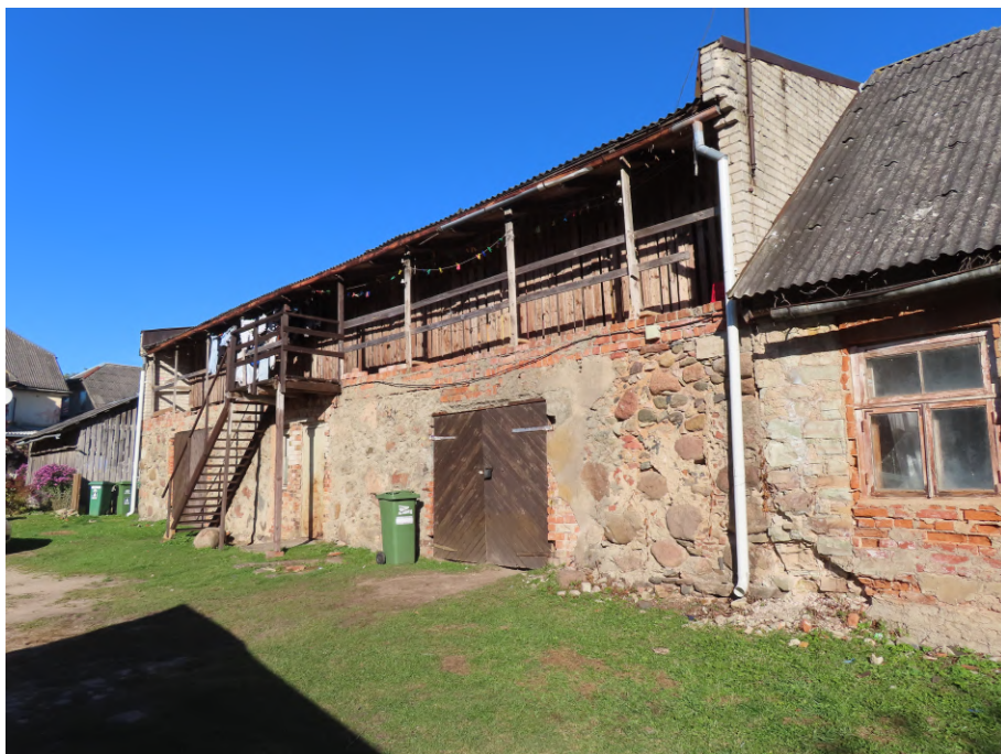
Riigas_3_5_88130010004007 _fasade1 Skats uz ēku no dienvidem.
