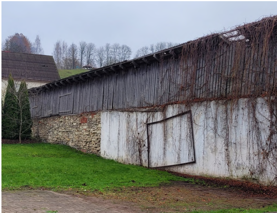
Riigas_13_88130040012008 _009_fasade2 Skats uz ēku no dienvidrietumiem.
