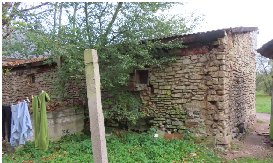
Ventspils_15_17_88130020129 004_fasade2 Skats uz ēku no ziemeļrietumiem.
