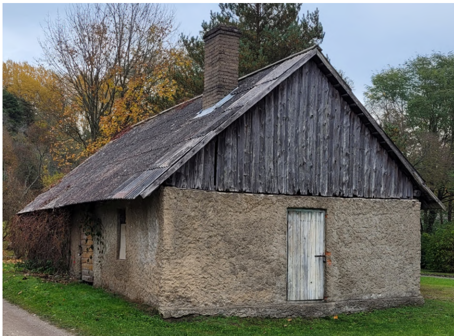
Ventspils_19_88130020023014 _fasade1 Skats uz ēku no rietumiem.
