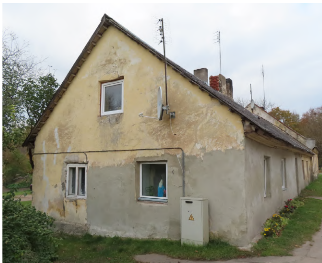
Ventspils_15_17_88130020129001_fasade1 Skats uz ēku no dienvidaustrumiem.
