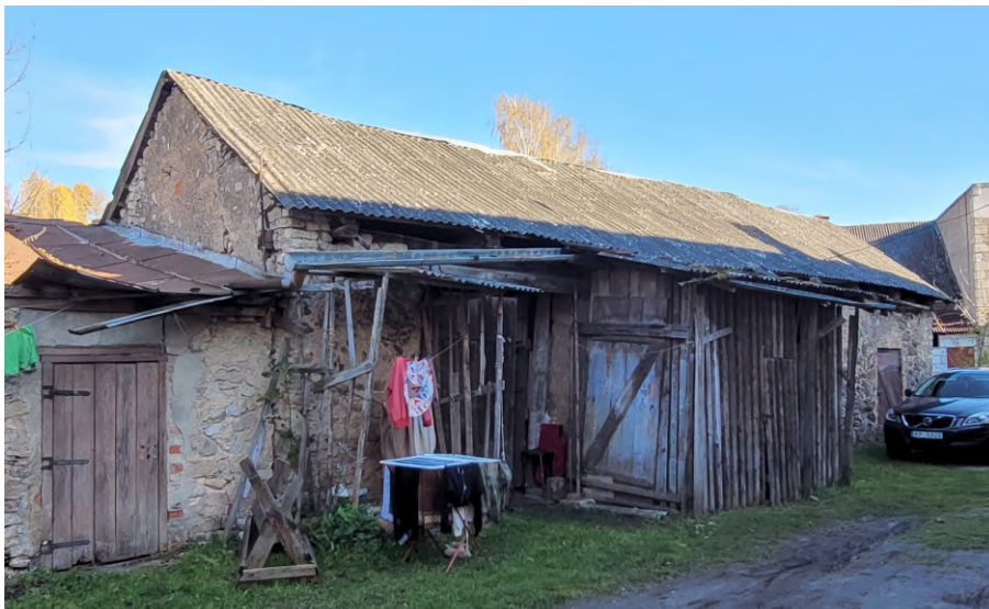
Riigas_9_88130010003005_ fasade1 Skats uz ēku no rietumiem.
