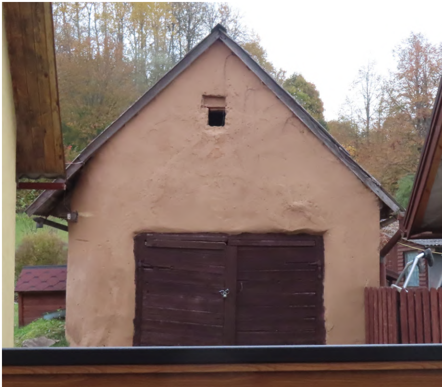
Ventspils_18_88130010094002 _fasade1 Skats uz ēku no rietumiem.
