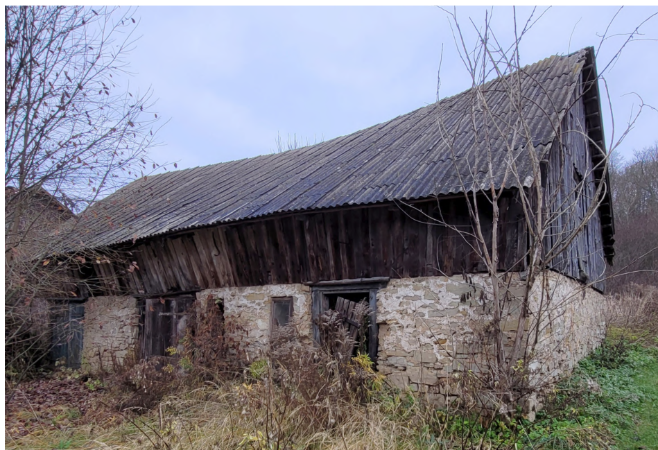
Riigas_23_88130040015003_fasade1 Skats uz ēku no dienvidiem.
