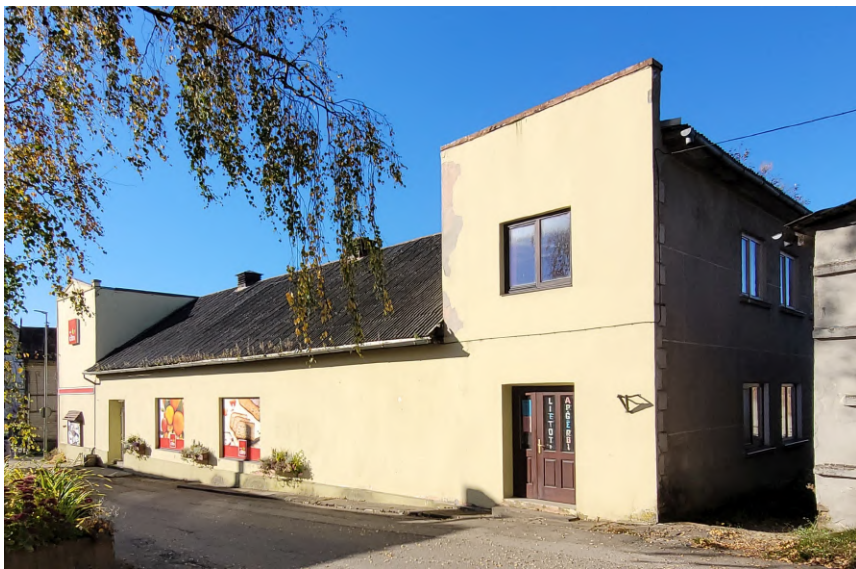
Pilskalna_1_88130010088006_ fasade1 Skats uz ēku no ziemeļaustrumiem.
