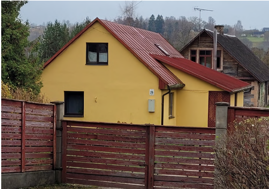
Riigas_26_88130040039001_ fasade1 Skats uz ēku no ziemeļiem.
