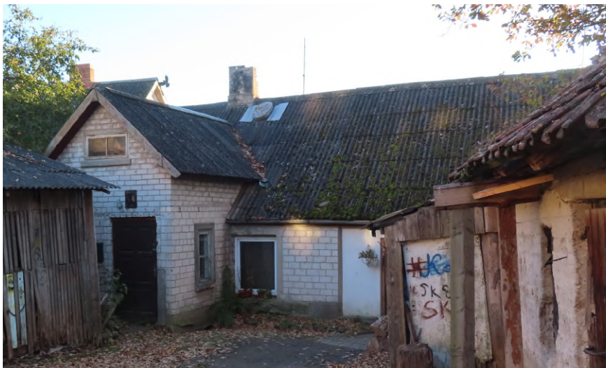
Riigas_4_6A_88130020010001 _fasade2 Skats uz ēku no ziemeļiem.
