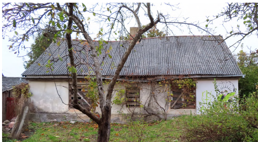
Avotu_3_88130020148001_ fasade2 Skats uz ēku no dienvidaustrumiem.
