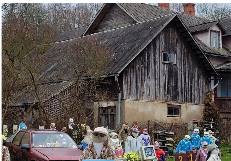
Riigas_19_88130040003004_ fasade1 Skats uz ēku no rietumiem.
