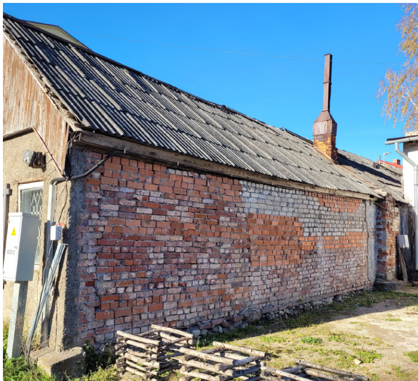
Pilskalna_2_88130040076001_ fasade2 Skats uz ēku no dienvidaustrumiem.
