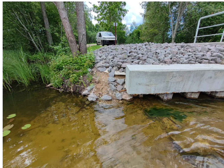
K1 kanāla ieplūdes kreisā krasta nostiprinājuma noslīdējums
