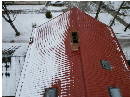
attēls 4.8.10 Skolas ēkas jumts
