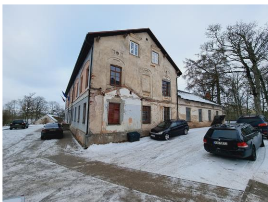
attēls 4.19.7 Ēkas ziemeļu fasāde
