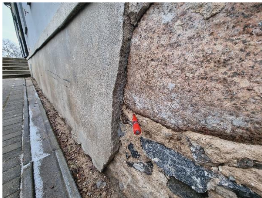
attēls 4.1.1. Dienvidu fasādes cokola daļa.
