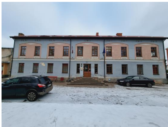
attēls 4.19.1 Ēkas rietumu fasāde
