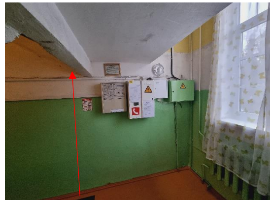
attēls 4.10.4. Augstums starp pārsegumiem ~2,0m
