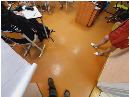
attēls 4.12.3 Otrā stāva preskartona grīdas segums
