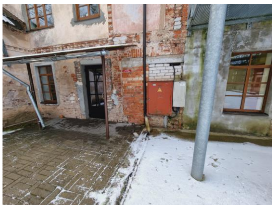
attēls 4.19.9 Ēkas ziemeļu fasāde
