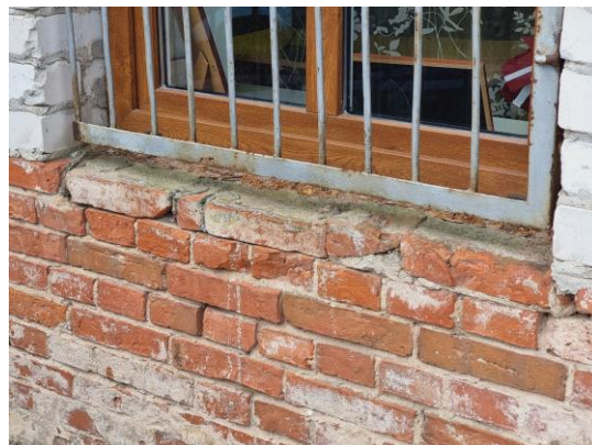
attēls 4.2.2 Ēkas austrumu puses ārsienas mūris
