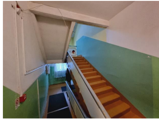
attēls 4.10.2. Centrālā kāpņu telpa
