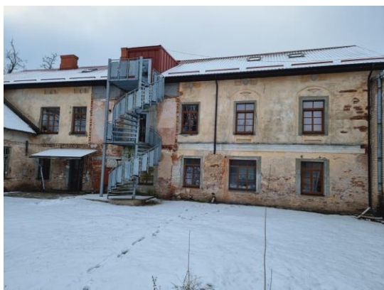
attēls 4.19.3 Ēkas ziemeļu fasāde
