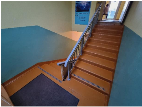
attēls 4.10.1. Centrālā kāpņu telpa.
