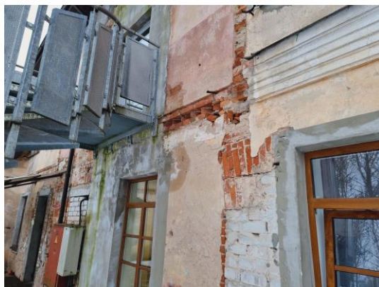
attēls 4.2.6 Pagalma puses mūra aizpildījumi
