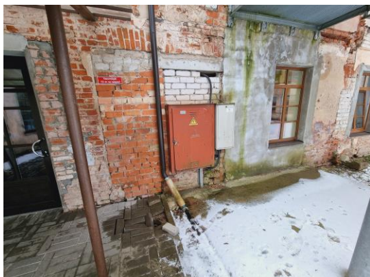
attēls 4.2.5 Pagalma puses mūra aizpildījumi
