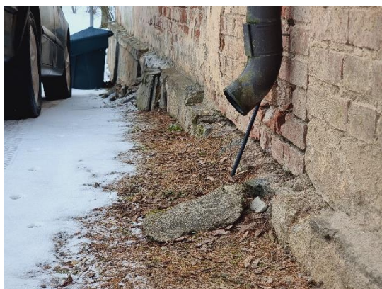
attēls 4.8.21 Nepilnvērtīga notekūdeņu novadīšana
