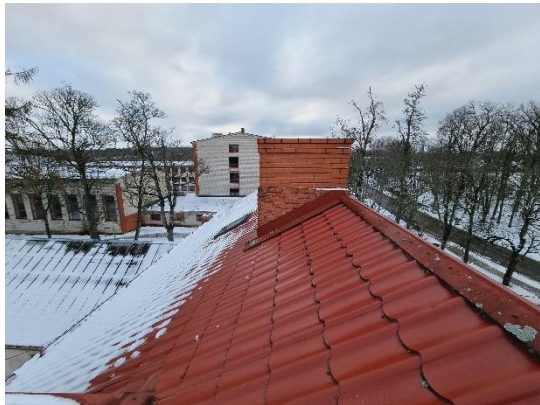
attēls 4.8.7 Skolas ēkas jumta segums
