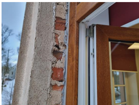
attēls 4.13.8 Trešā stāva logu ailes ārējā apdare.
