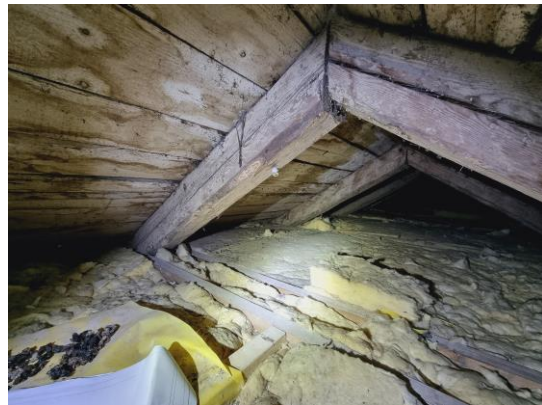
attēls 4.8.2 Skolas ēkas jumta konstrukcijas. Bēniņi
