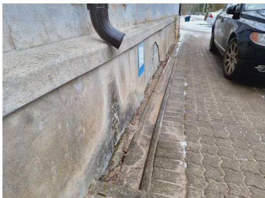
attēls 4.1.3. Dienvidu fasādes cokola daļa.
