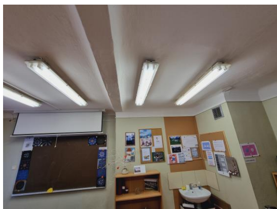
attēls 4.6.3 Pirmā stāva griesti
