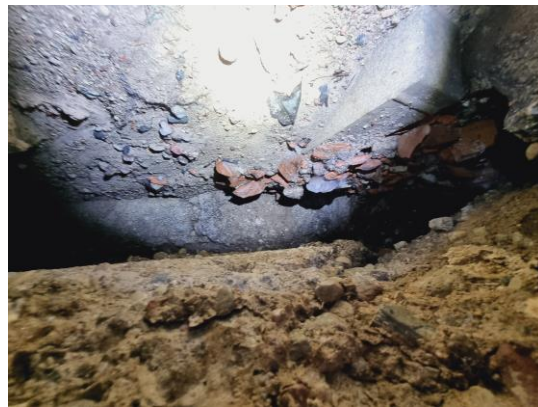
attēls 4.1.14 Izskalojumi starp virsmas segumu un grunti
