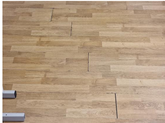
attēls 4.12.2 Trešā stāva lamināta dēļu grīdas segums
