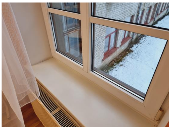
attēls 4.13.7 PVC profila rāmja logs
