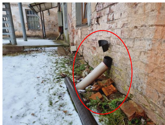
attēls 4.8.16 Nolauzts apakšējās posms
