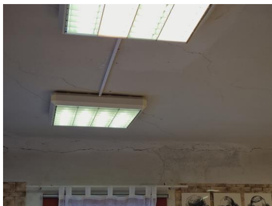
attēls 4.6.2. Otrā stāva pārsegums
