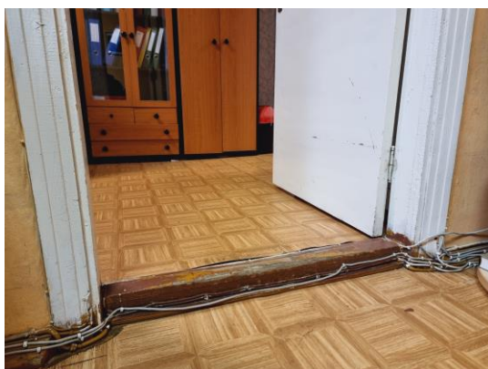
attēls 4.13.5 Iekšdurvis ar sliekšņiem
