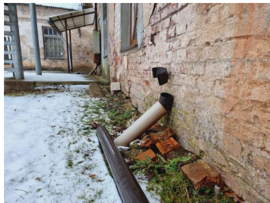
attēls 4.1.2. Pamatnes izskalojumi ziemeļu pusē
