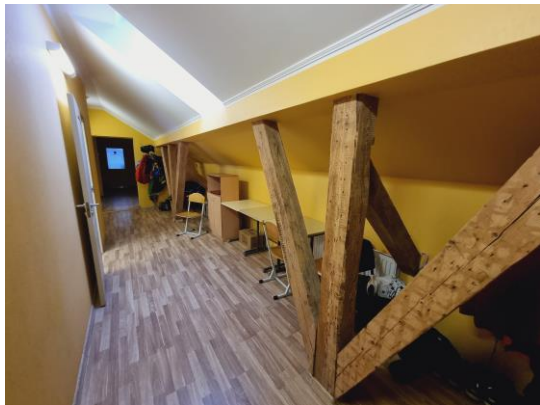
attēls 4.8.1 Skolas ēkas jumta konstrukcijas. 3.stāvs
