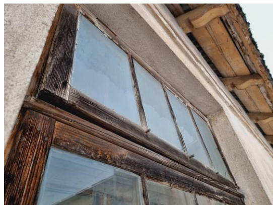
attēls 4.8.4 Zāles ēkas jumta konstrukcijas
