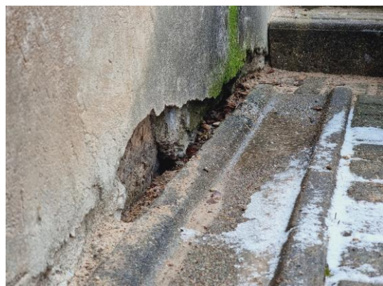
attēls 4.1.10 Apmalē iestrādātas betona notekrenes
