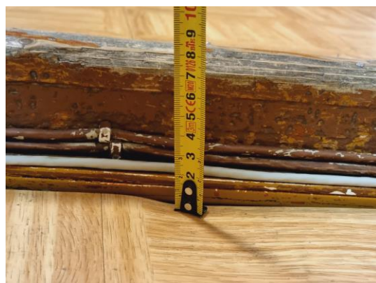
attēls 4.13.6 Iekšdurvis ar sliekšņiem
