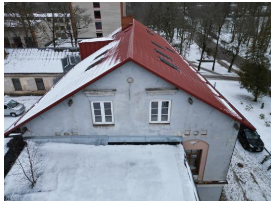
attēls 4.8.8 Skolas ēkas jumts
