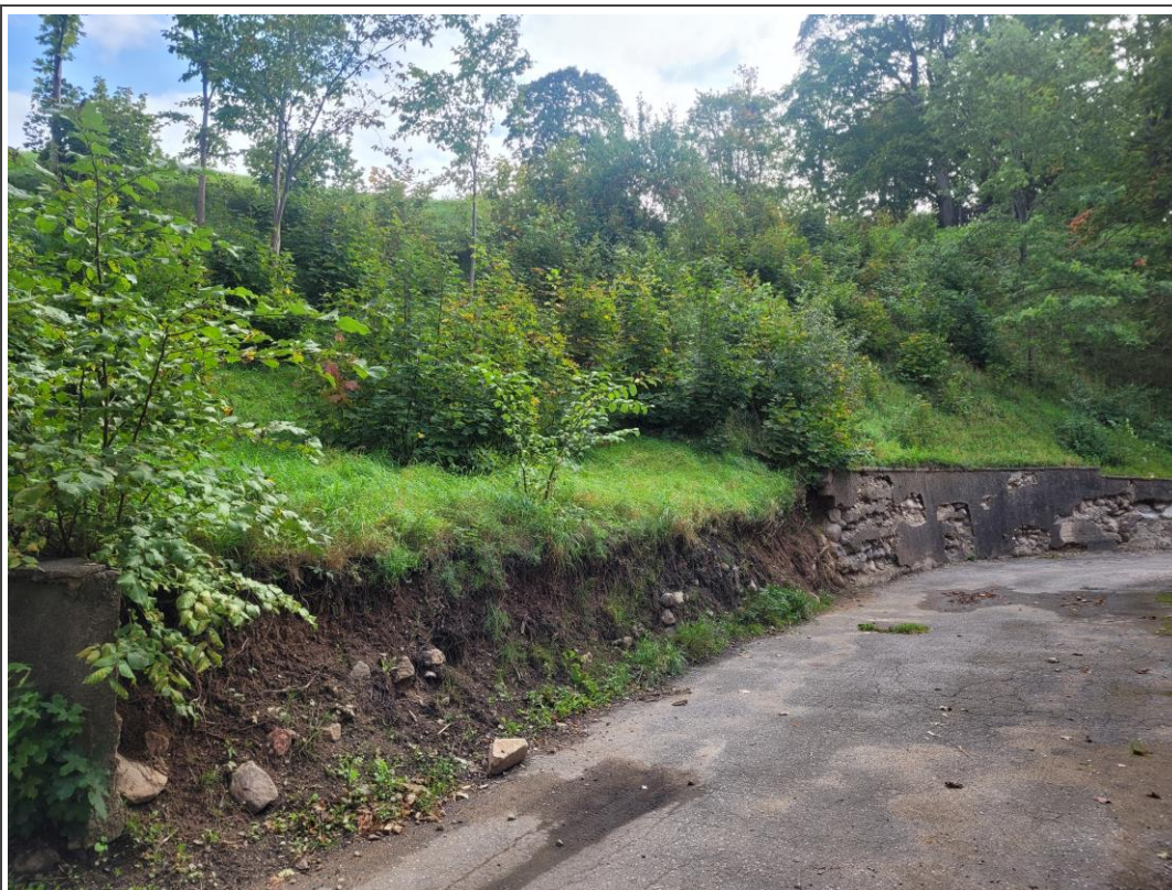
11.attēls. Atbalstsienas 3.Posms – atbalstsiena ir nobrukusi.
