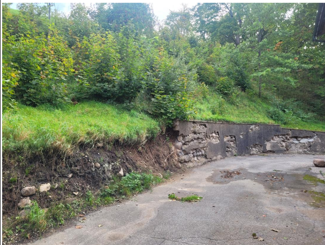
12.attēls. Atbalstsienas 3.Posms – atbalstsiena ir nobrukusi.
