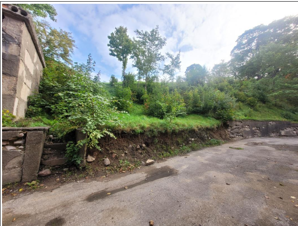
13.attēls. Atbalstsienas 3.Posms – atbalstsiena ir nobrukusi.
