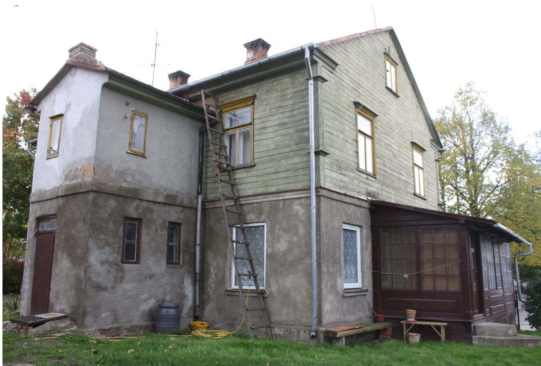
Rozju_3_88010130116001_fasade4 Skats uz ēku no ziemeļaustrumiem.
