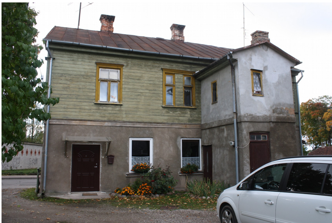
Rozju_3_88010130116001_fasade3 Skats uz ēku no austrumiem.
