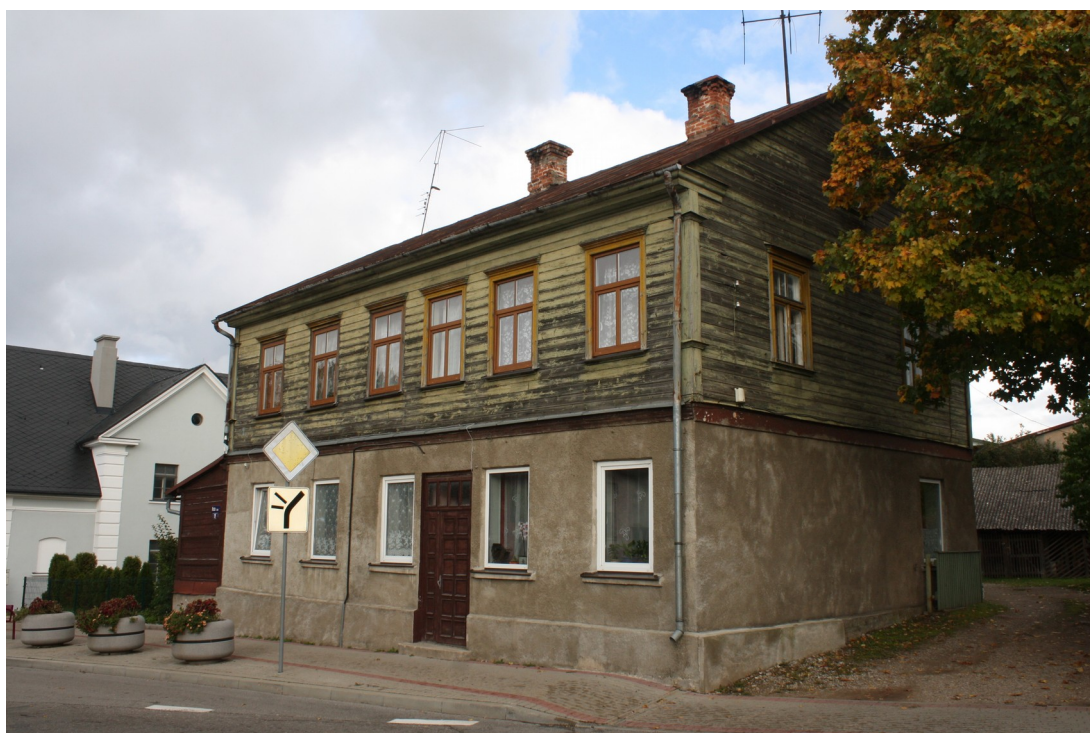
Rozju_3_88010130116001_fasade2 Skats uz ēku no dienvidrietumiem.
