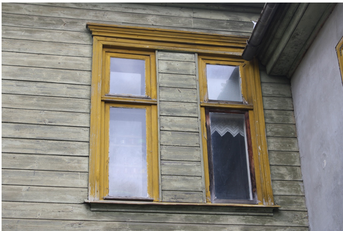
Rozju_3_88010130116001_logs4 Sākotnējie (1885.-1888.g.) logi ar oriģinālo ailas apdari.
