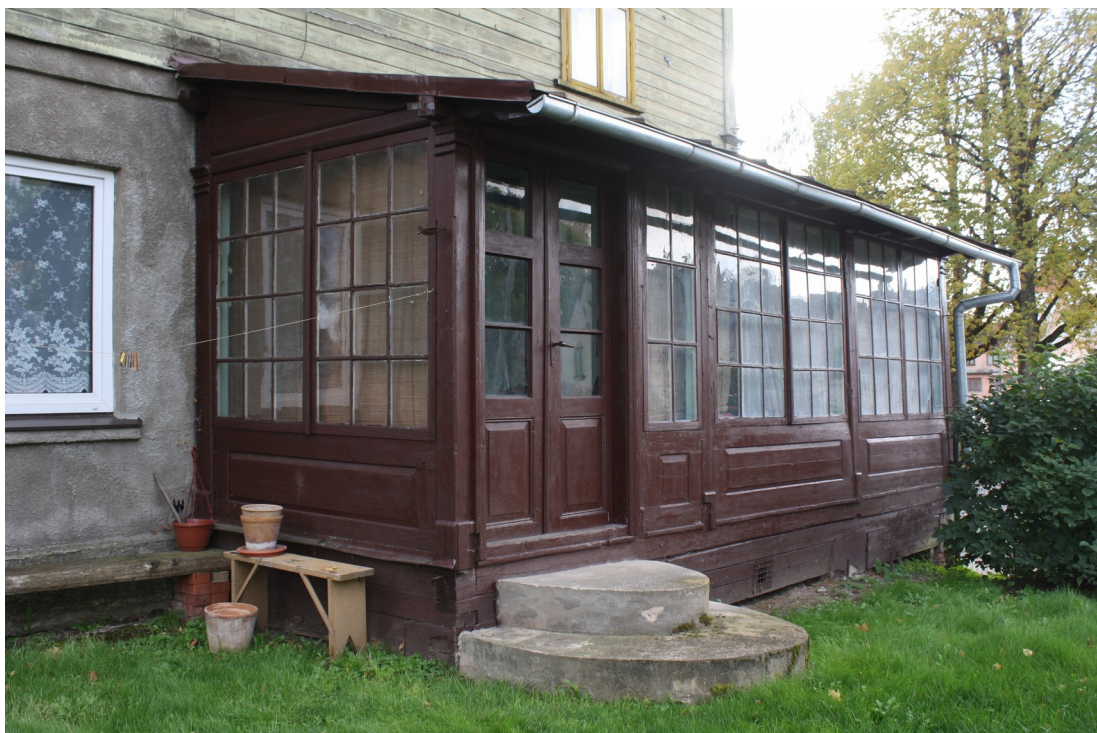
Rozju_3_88010130116001_fragments2 Sākotnējā (1885.-1888.g.) veranda.
