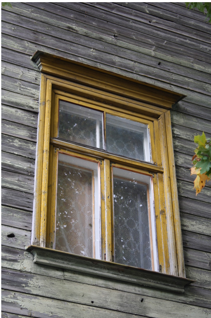
Rozju_3_88010130116001_logs2 Sākotnējs (1885.-1888.g.) logs ar oriģinālo ailas apdari.
