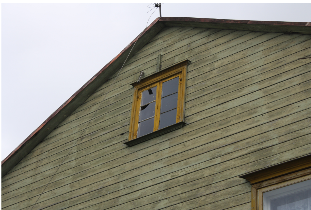
Rozju_3_88010130116001_logs3 Sākotnējs (1885.-1888.g.) logs ar oriģinālo ailas apdari.
