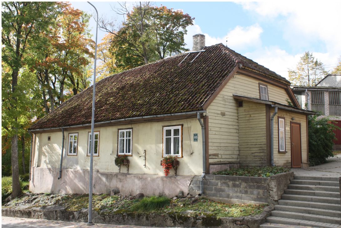
Lielaa_40_88010120231001_fasade1 Skats uz ēku no austrumiem.
