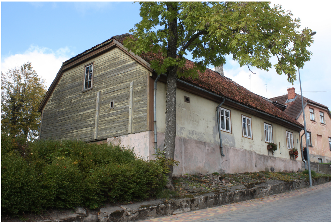
Lielaa_40_88010120231001_fasade2 Skats uz ēku no dienvidiem. Divas malējās logailas kreisajā pusē izbūvētas 20.gs.2.pusē.
