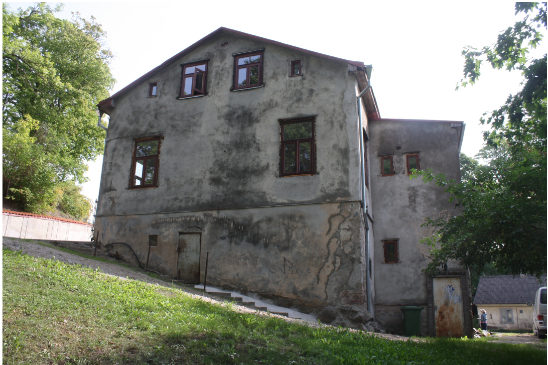
Lielaa_39_88010130043001_fasade8 Skats uz ēku no rietumiem.
