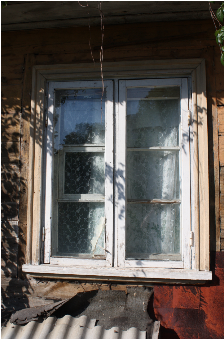
Liela_32A_88010120191002_logs4 Sākotnējs logs. Mainītas ārējās vērtnes. Daļēji saglabājies oriģinālais aprīkojums.
