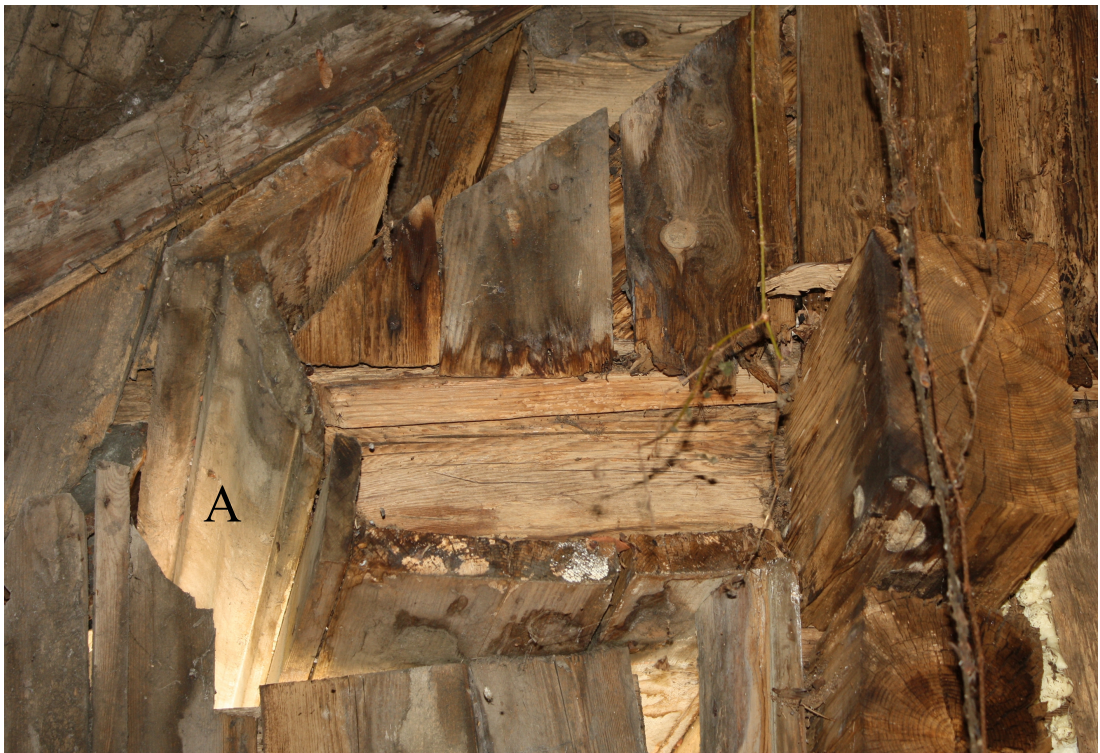
Liela_32A_88010120191002_dzega1 Sākotnēja dēļu dzega (A). Skats no piebūves.
