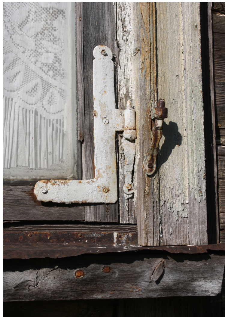
Liela_32A_88010120191002_logs3 Atkārtoti izmantots sākotnējs loga aprīkojums. Saglabājušies slēgu viru kāši.
