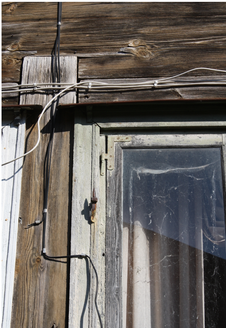
Liela_32A_88010120191002_logs2 Atkārtoti izmantots sākotnējs loga aprīkojums.
