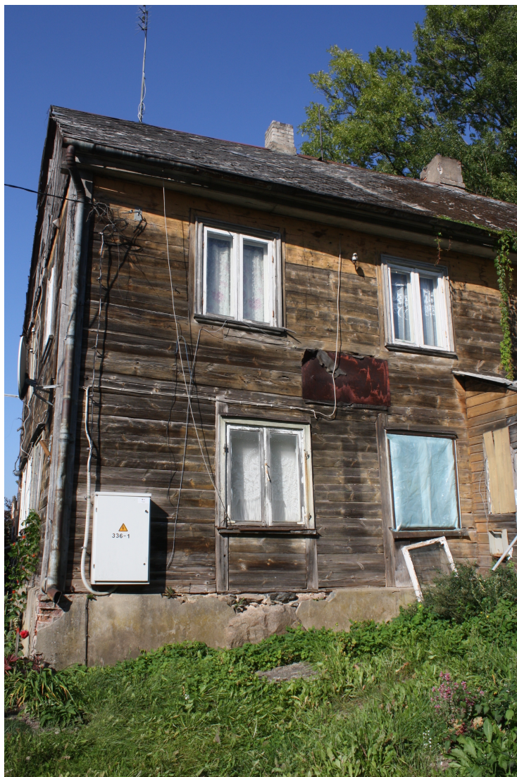
Lielaa_32A_88010120191002_ fasade3 Skats uz ēkas austrumu fasādes fragmentu.
