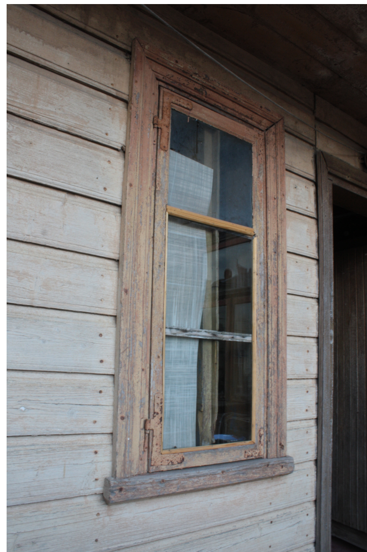
Liela_29b_88010130141003_logs3 Vēsturisks logs ar, domājams, atkārtoti izmantotu aprīkojumu.
