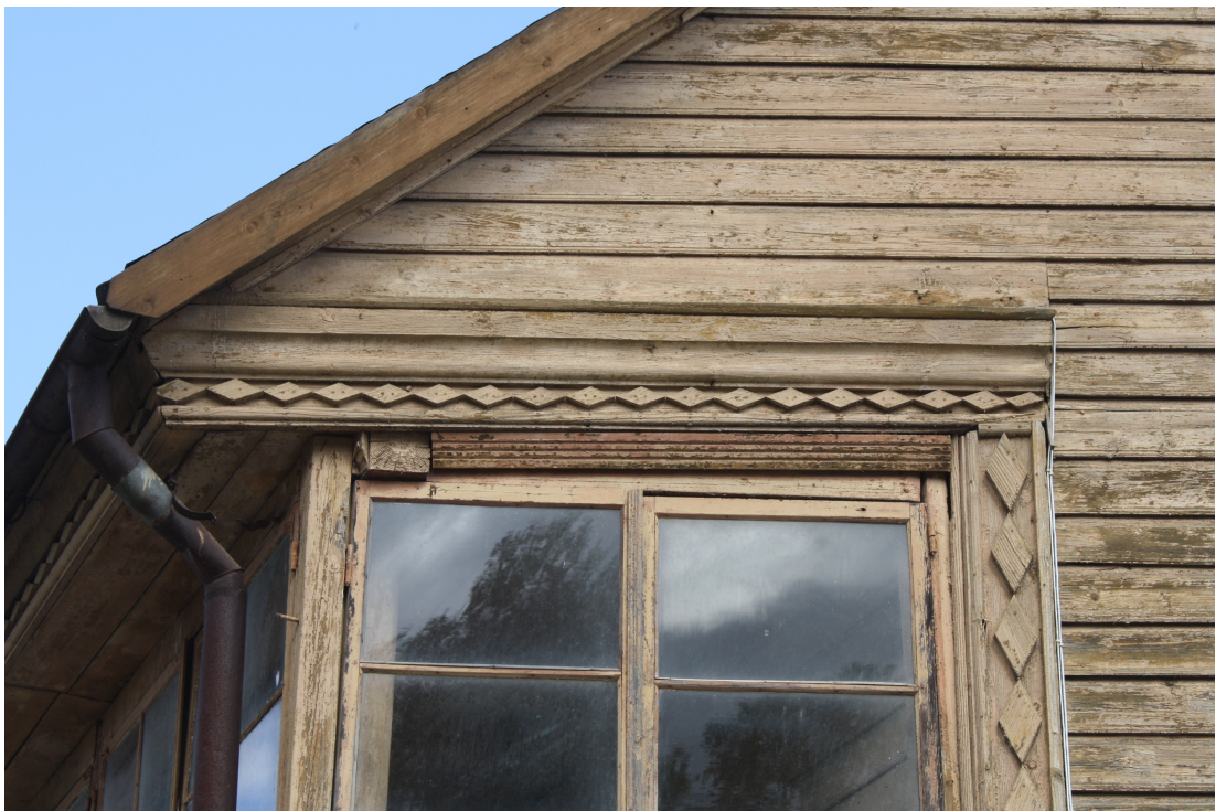
Liela_29b_88010130141003_detala2 Skats uz dienvidu fasādes fragmentu ar sākotnējo dzegu un dekoratīvajām apdares detaļām.
