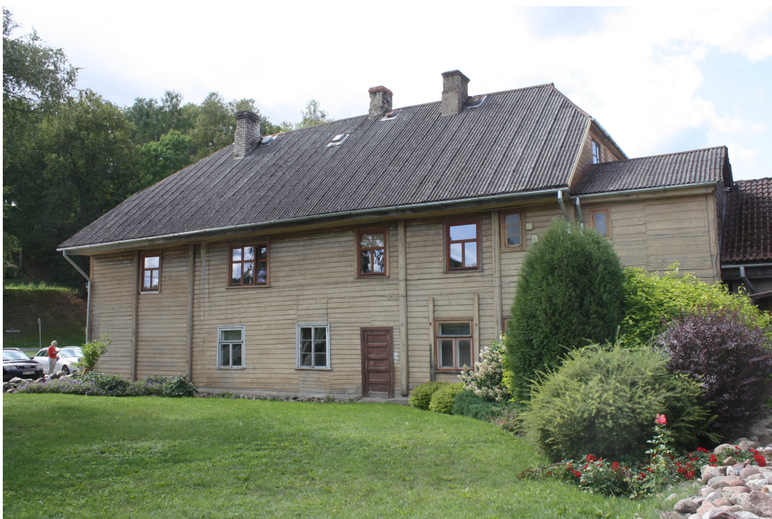
Lielaa_29b_88010130141003_ fasade2 Skats uz ēku no ziemeļaustrumiem.
