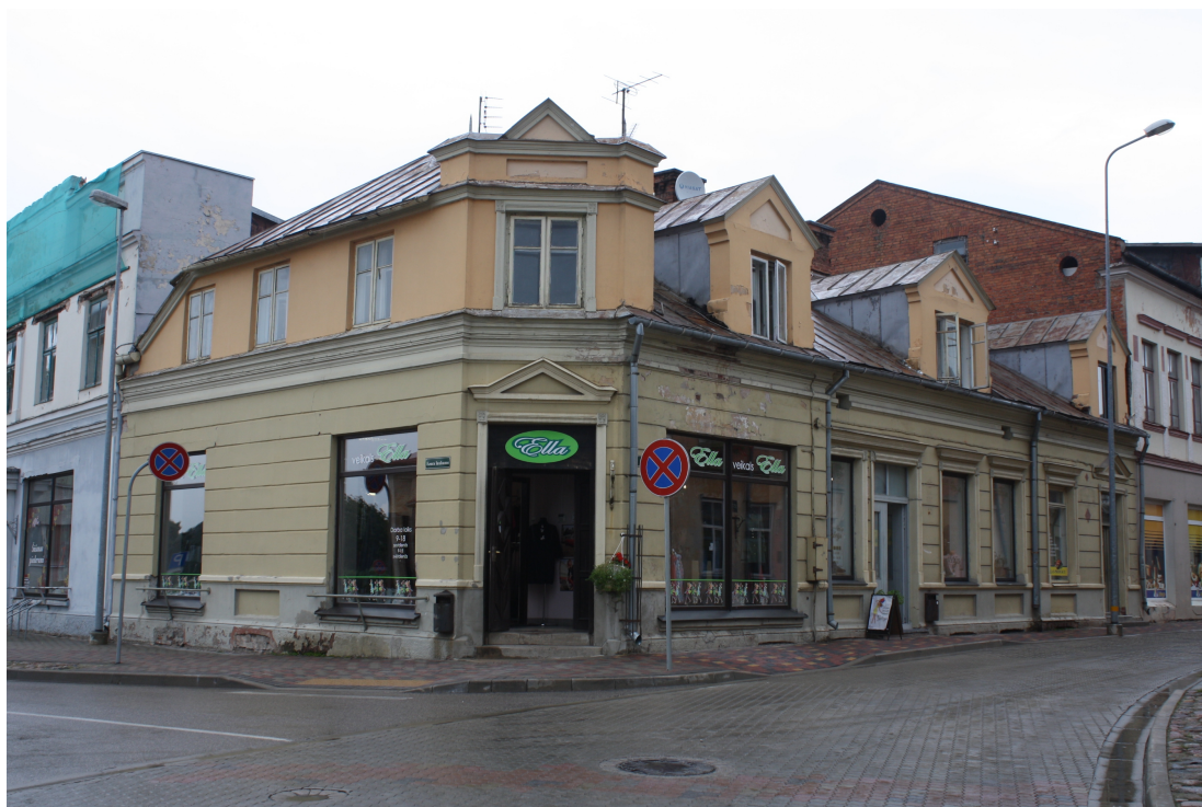
Liela_24_1_88010120187001_fasade1 Skats uz ēku no dienvidrietumiem.
