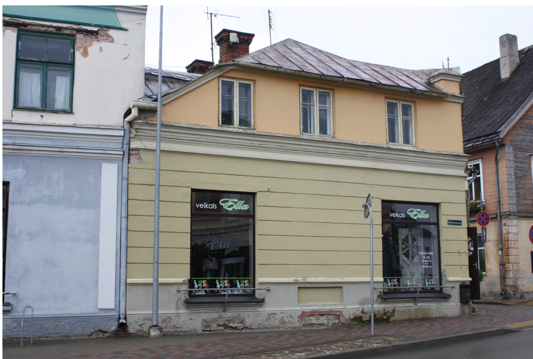
Liela_24_1_88010120187001_fasade2 Skats uz ēkas fasādi pret Ezera laukumu no rietumiem. Sākotnēji zelinī tikai 2 labās puses logailas.
