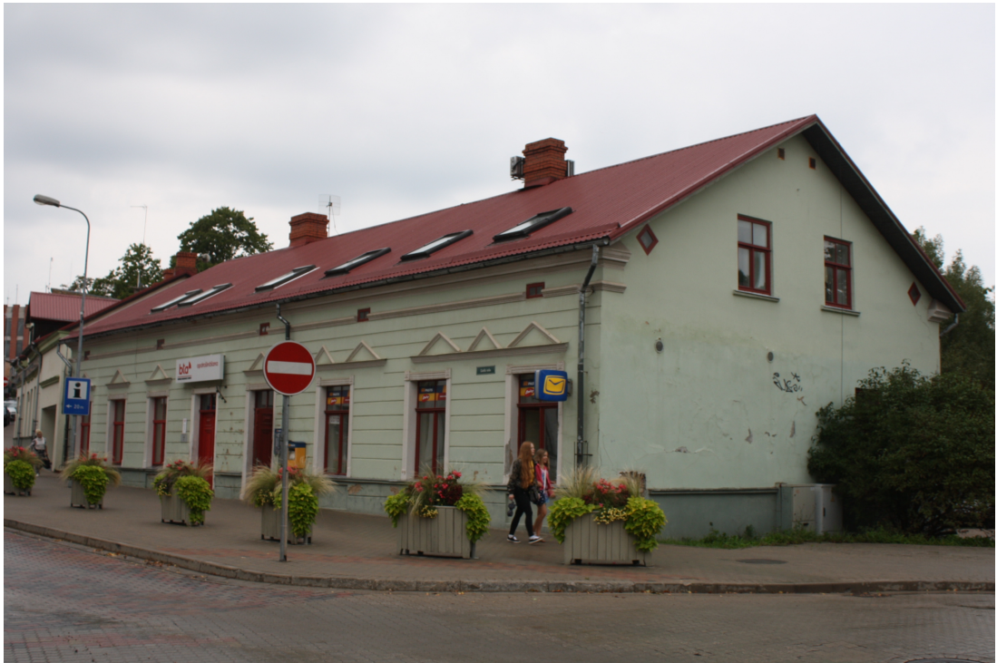
Liela_20_88010090102001_fasade2 Skats uz ēku no dienvidaustrumiem.
