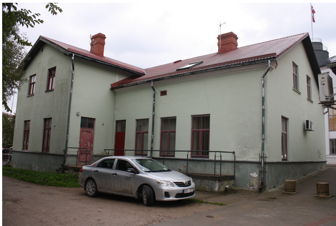
Liela_20_88010090102001_fasade5 Skats uz ēku no ziemeļrietumiem.
