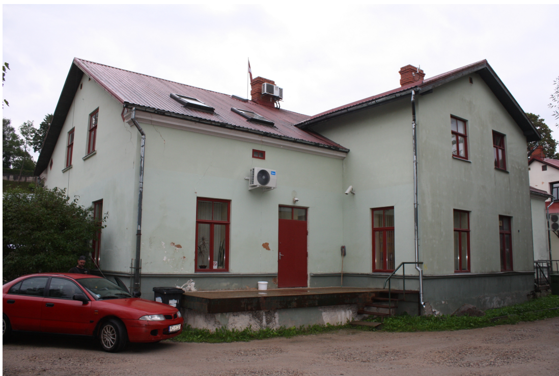
Liela_20_88010090102001_fasade6 Skats uz ēku no ziemeļaustrumiem.
