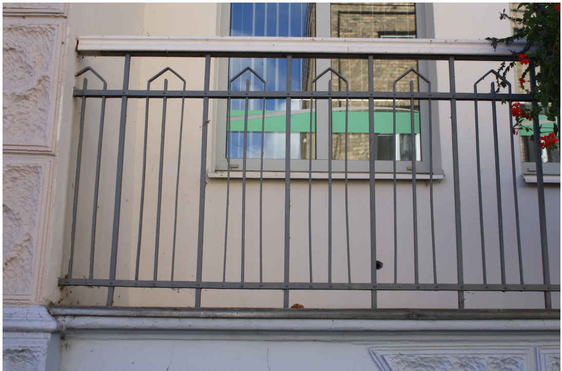
Lielaa_17_88010090036001_detala1 Sākotnējās metālkaluma margas fragments.
