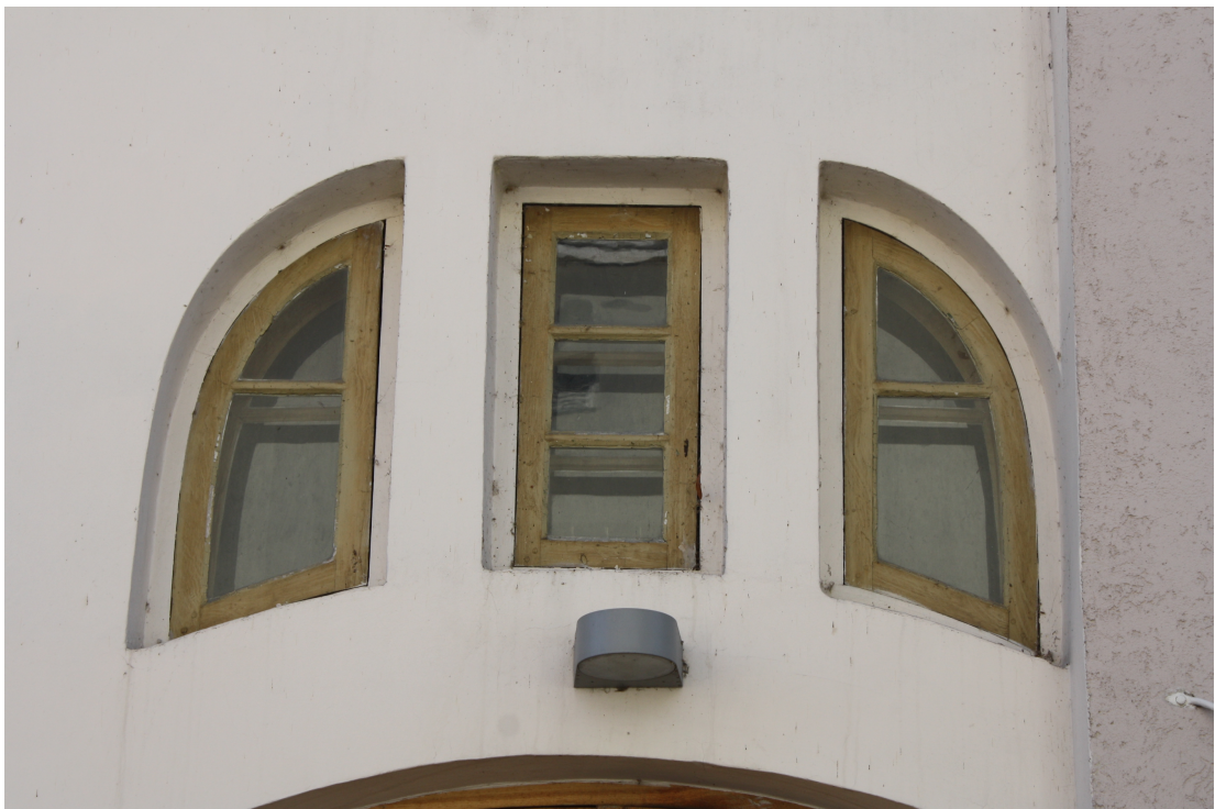
Lielaa_17_88010090036001_logs1 Sākotnējie logi ielas fasādē.
