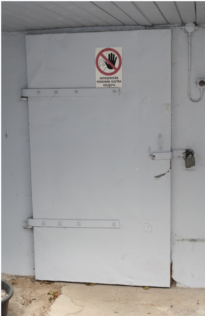
Lielaa_17_88010090036001_durvis1 Domājams, ar skārdu apšūtas sākotnējās durvis.
