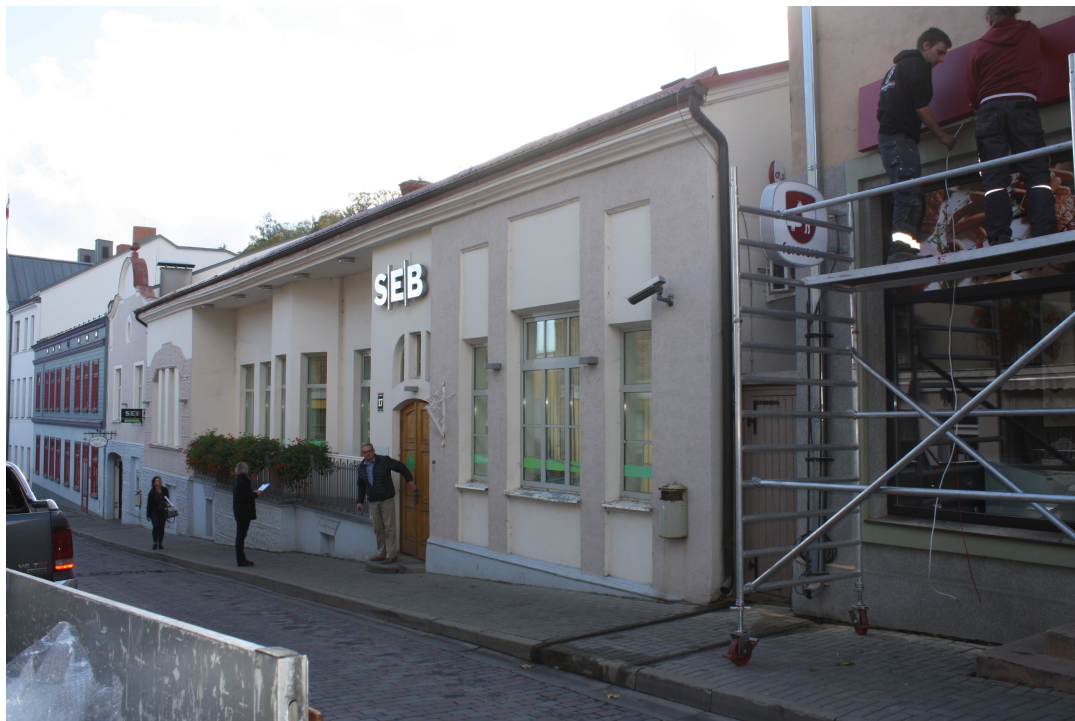
Lielaa_17_88010090036001_fasade2 Skats uz ēku no ziemeļrietumiem.
