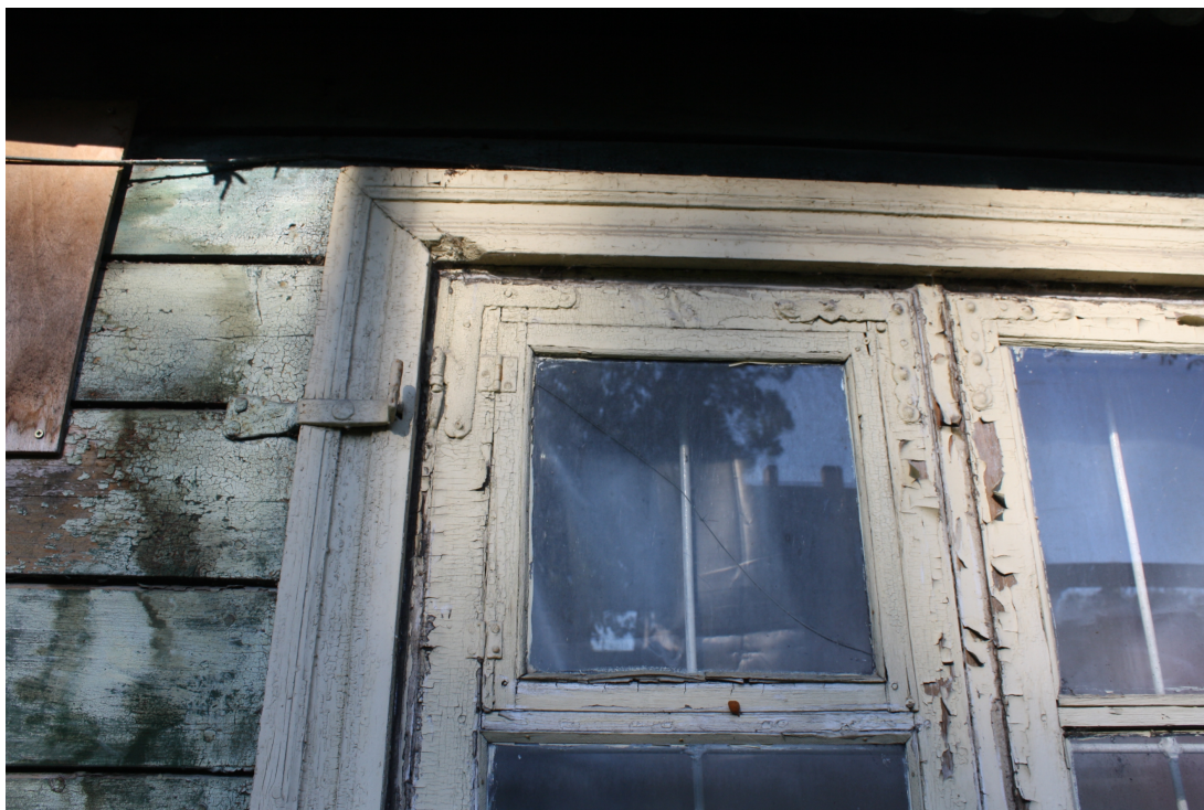
Liela_10_88010090137001_logs2 Atkārtoti izmantots 18.gs. (rokoko) aprīkojums vērtņēm. Slēgu viras kāsis – 19.gs.
