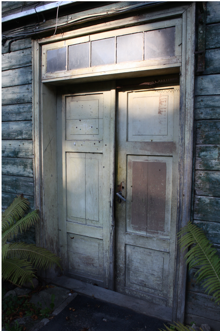
Lielaa_10_88010090137001_durvis1 Saglabājusies vēsturiskā ieejas durvju aploda ar virām (no telpas puses).
