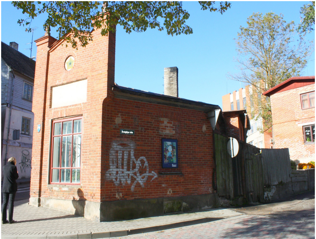
Lielaa_8A_88010090186002_fasade3 Skats uz ēku no ziemeļaustrumiem (fasāde pret Zvaigžņu ielu).
