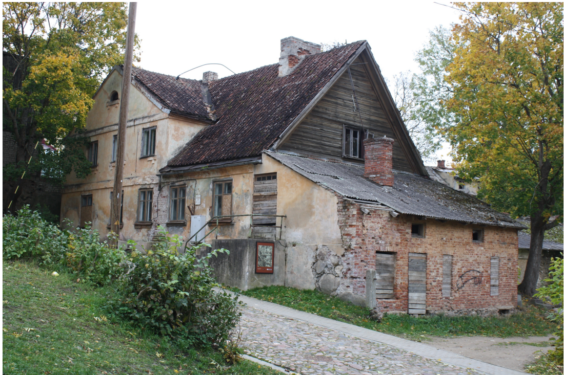
Kaleeju_2_88010130122001_fasade2 Skats uz ēku no rietumiem. Piebūve (20.gs.sāk.), domājams, uzcelta uz vecākām konstrukcijām.
