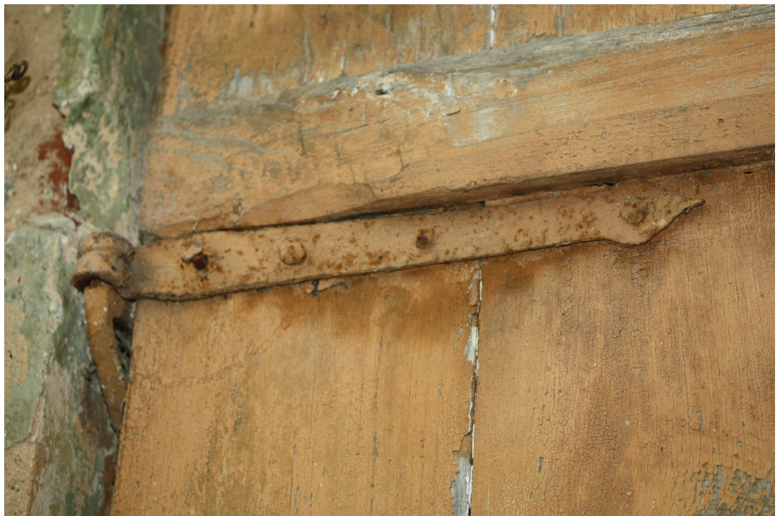
Kaleeju_2_88010130122001_slegis3 Sākotnējā slēģa fragments ar lentveida kāšu viru.
