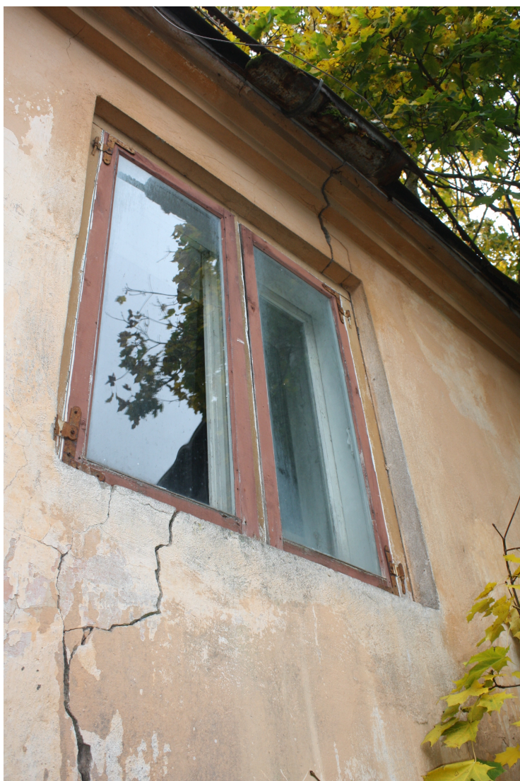
Kaleeju_2_88010130122001_logs1 Vēsturiska loga aploda ēkas ziemeļaustrumu fasādes zelminī. Kāšu viras izmantotas atkārtoti.
