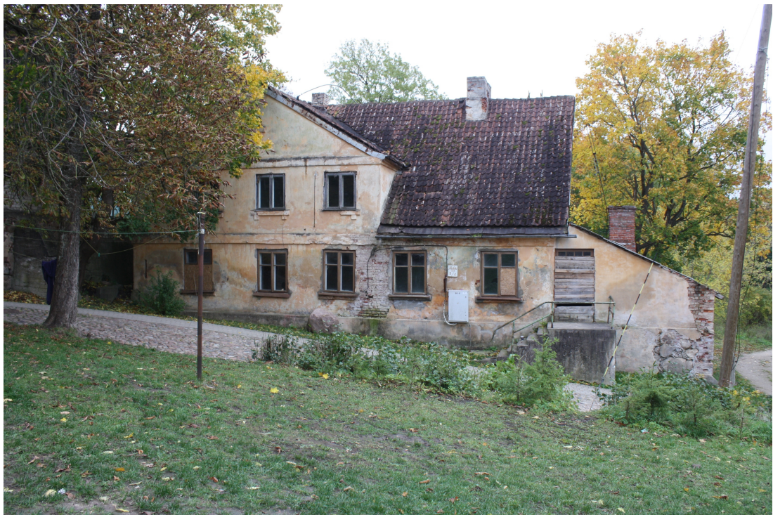
Kaleeju_2_88010130122001_fasade3 Skats uz ēku no ziemeļrietumiem.
