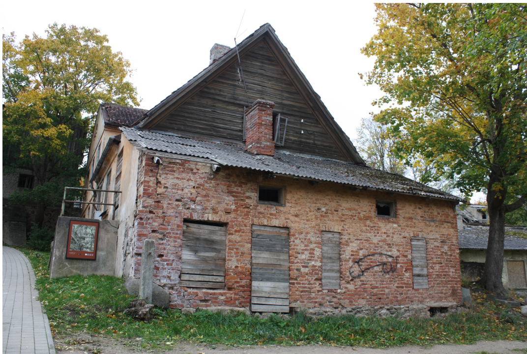
Kaleeju_2_88010130122001_fasade4 Skats uz ēku no dienvidrietumiem. Domājams, fasāde nav bijusi apmesta.
