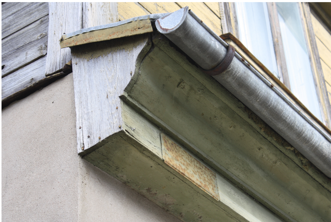
Bazniicas_lauk_3_88010120053001_dzega1 Sākotnēja dēļu dzega, remontēta.
