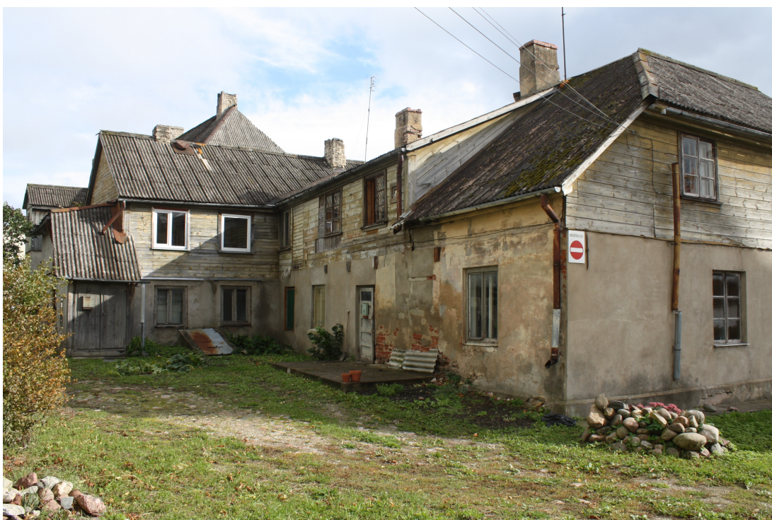
Bazniīcas_lauk_3_88010120053001_fasade5 Skats uz ēku no ziemeļrietumiem.
