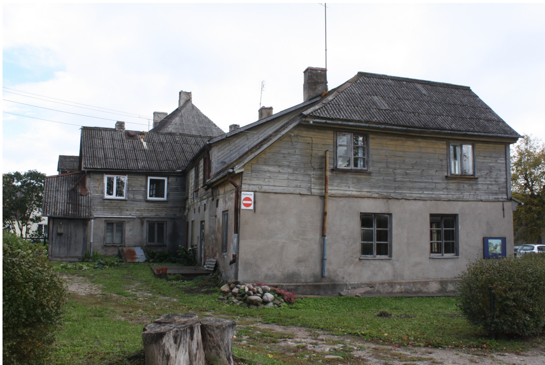
Bazniīcas_lauk_3_88010120053001_fasade3 Skats uz ēku no rietumiem.
