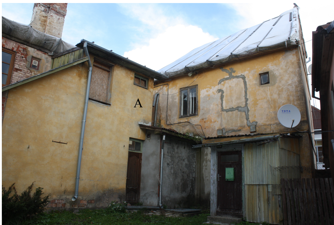
Bazniīcas_lauk_2_88010120211001_fasade4 Skats uz ēku no dienvidiem. 20.gs.2.pusē pārbūvēta 19.gs.4.cet. piebūve (A) un uzceltas jaunas.
