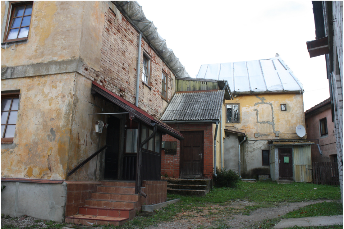
Bazniicas_lauk_2_88010120211001_fasade5 Skats uz ēku no dienvidrietumiem.
