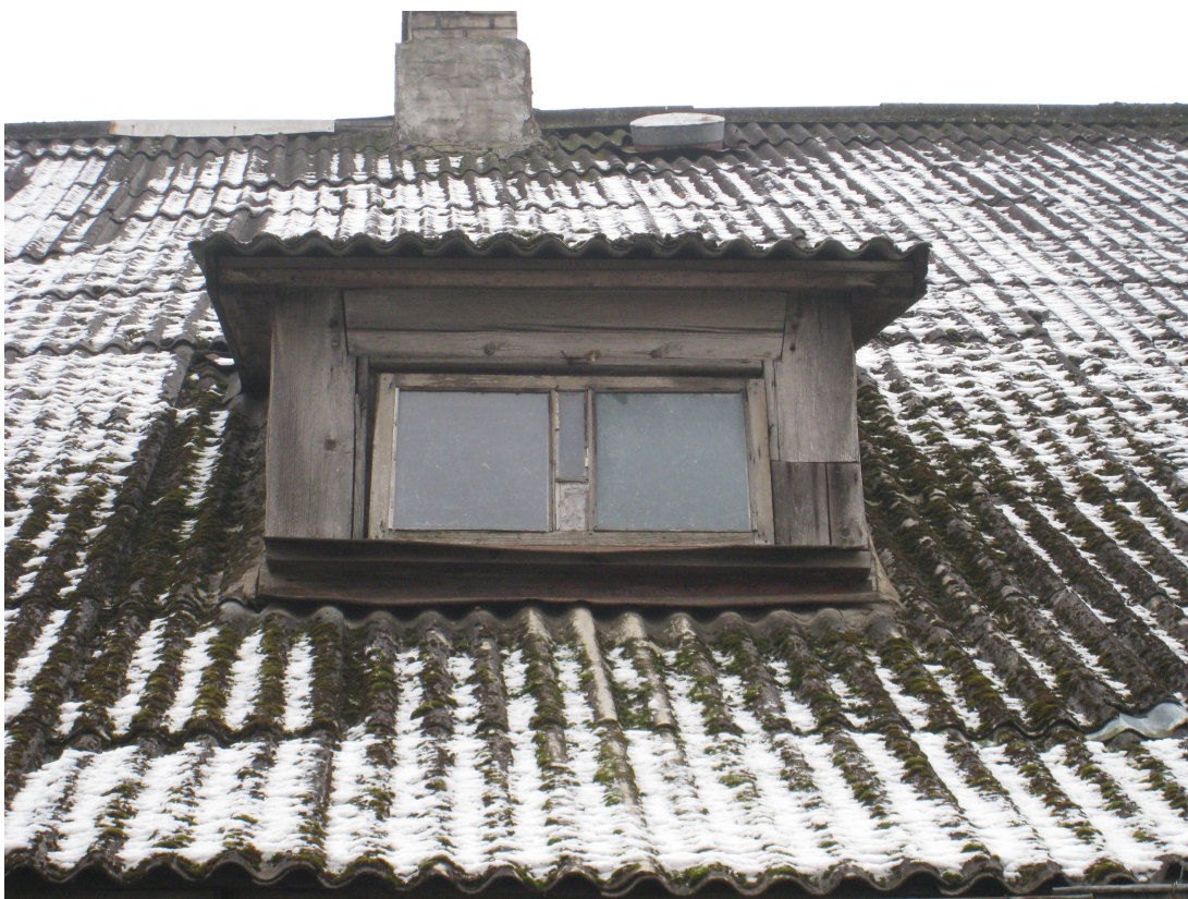
Bazniicas_lauk_1_88010120193001_fragments4 Sākotnēja pulsts tipa jumta izbūve ar vēsturisku vētrni.
