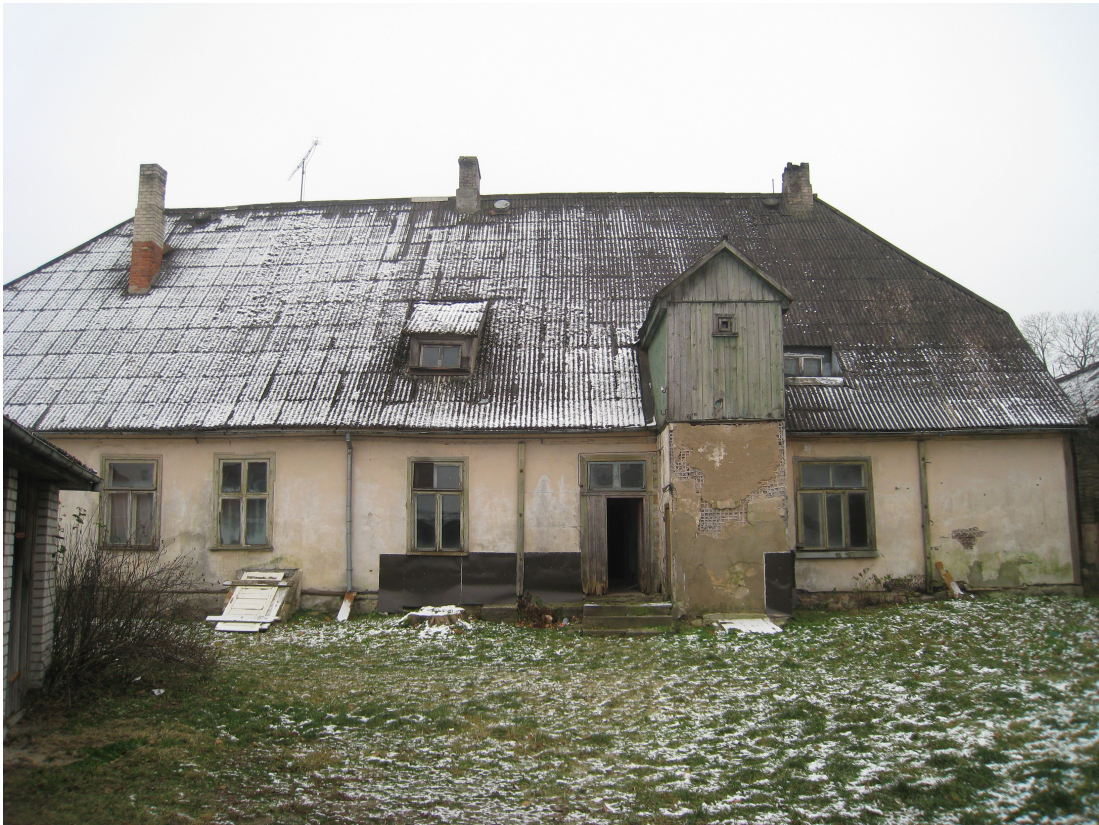
Bazniicas_lauk_1_88010120193001_fasade5 Skats uz ēku no ziemeļiem. Piebūve – 20.gs.2.puse.
