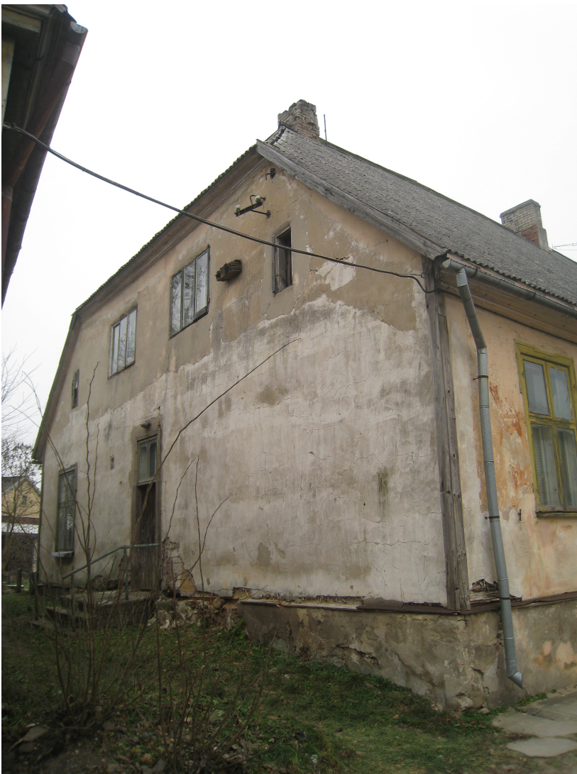
Bazniicas_lauk_1_880101201930 01_fasade6 Skats uz ēkas dienvidrietumu fasādi.
