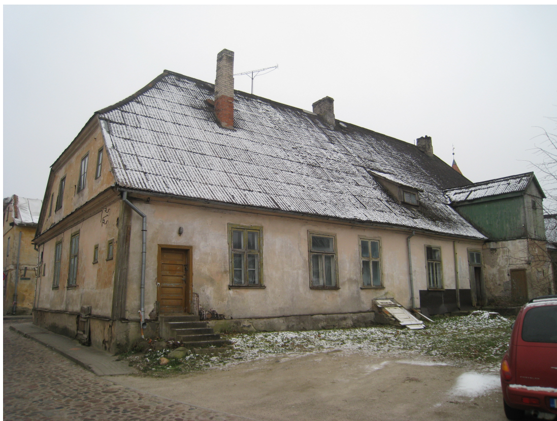
Bazniīcas_lauk_1_88010120193001_fasade4 Skats uz ēku no ziemeļaustrumiem.
