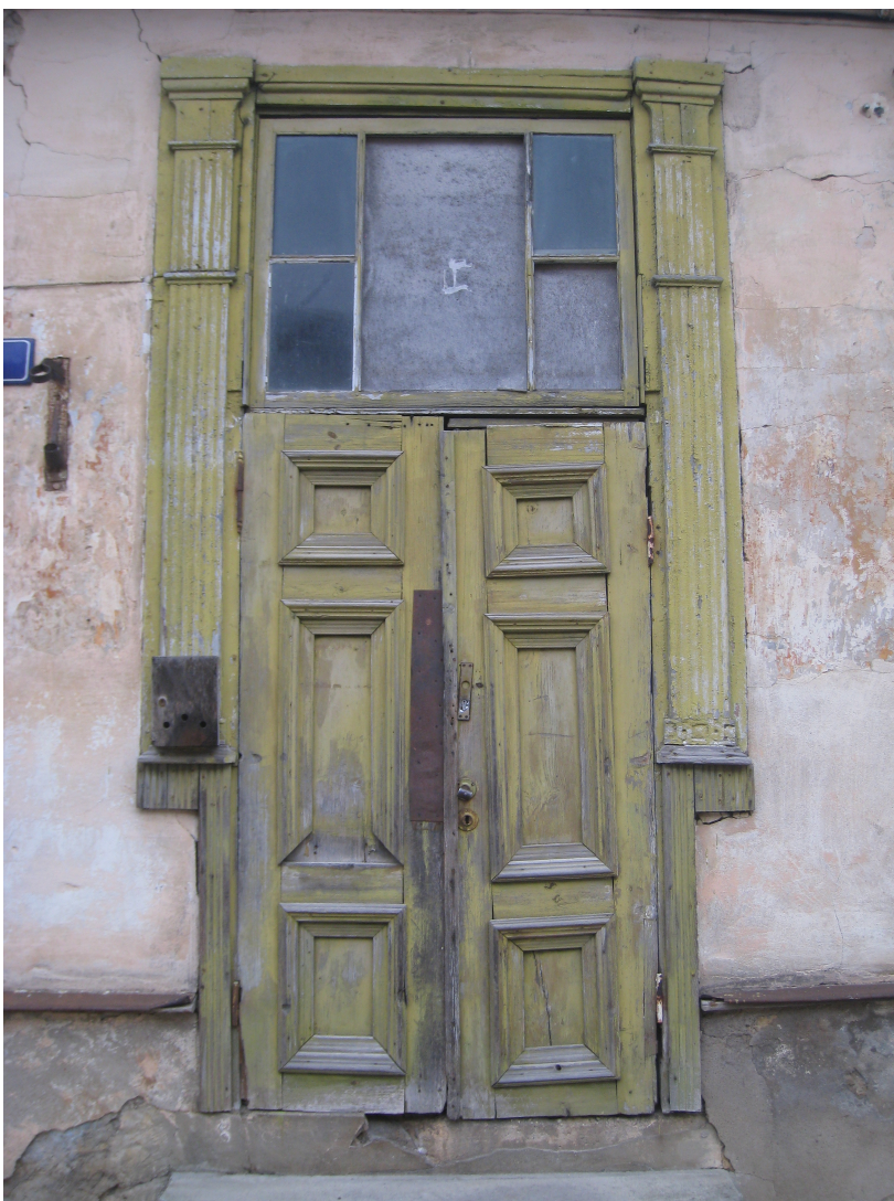
Bazniicas_lauk_1_880101201930 01_durvis1 Sākotnējais ieejas durvju portāls un aploda ar šķērsi. Durvju sliekšnis pazemināts 19.gs.beigās – 20.gs. sākumā. Esošās vērtnes – šī perioda vērtņu atdarinājums. Daļēji saglabājies un atkārtoti izmantots rokturis, noseglplāksne un stobrvira ar dekoratīvi virpotu galu.
