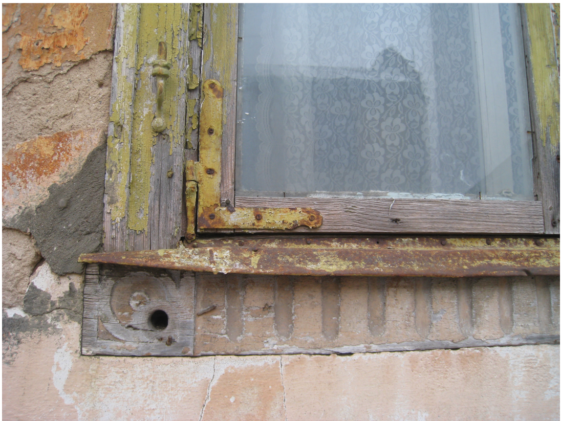
Bazniicas_lauk_1_88010120193001_logs3 Sākotnējais loga aprīkojums un klasicisma stilistikai raksturīga koka palodze.
