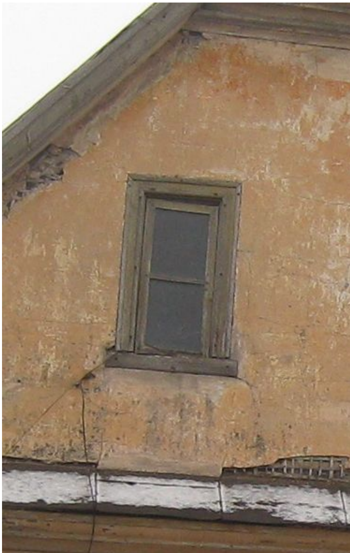
Bazniicas_lauk_1_88010120193001_logs3 Sākotnējais loga aprīkojums un klasicisma stilistikai raksturīga koka palodze.
