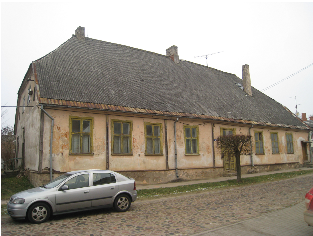
Bazniīcas_lauk_1_88010120193001_fasade1 Skats uz ēku no dienvidrietumiem.
