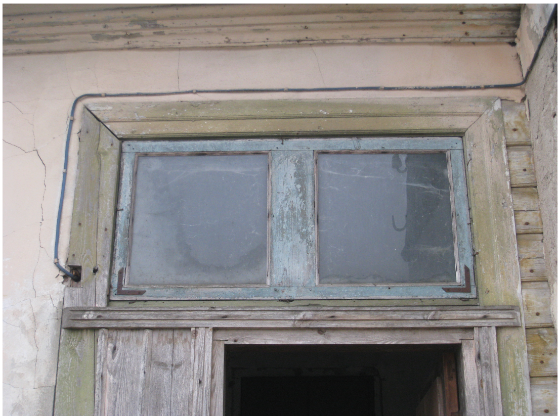
Baznīcas_lauk_1_88010120193001_durvis3 Sākotnēja durvju aila ar aplodu un noseglīstēm. Virslogs sekundārs.
