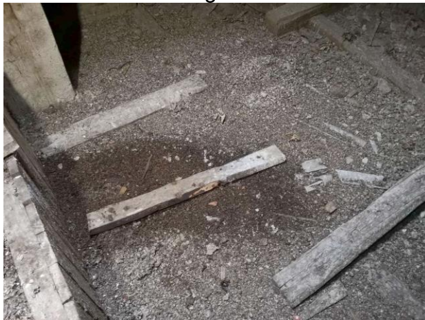
4.8.6 aptuveni 1m diametra slapjš plankums zem lūkas
