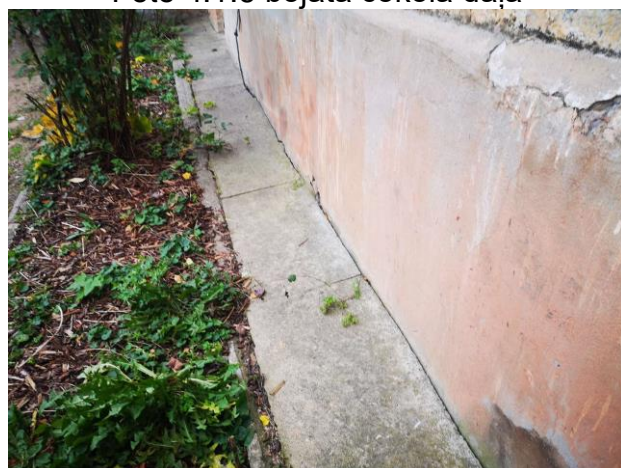
Foto 4.1.8 betona ēkas apmale
