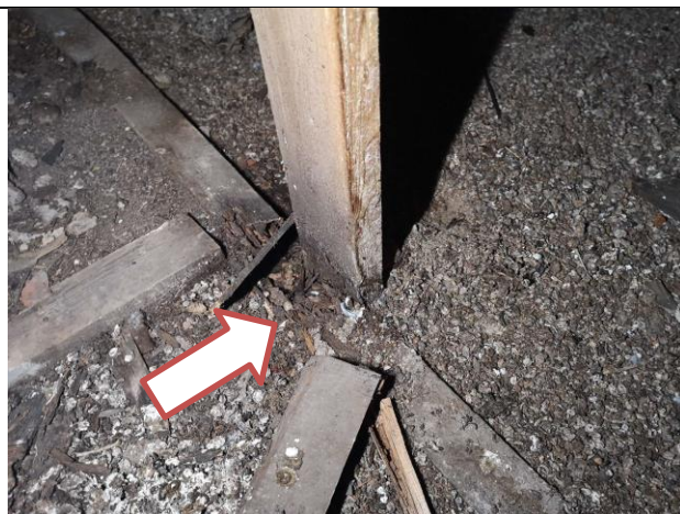
4.8.12 pastiprinājuma statnis nobalstīts uz izdedžiem
