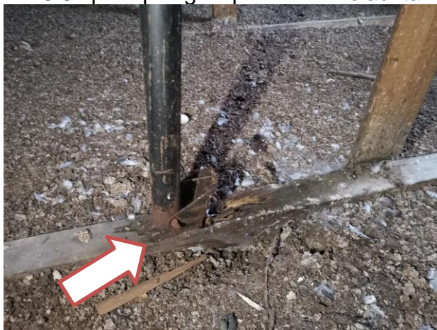
4.8.10 tērauda statņa balstījums sarūsējis
