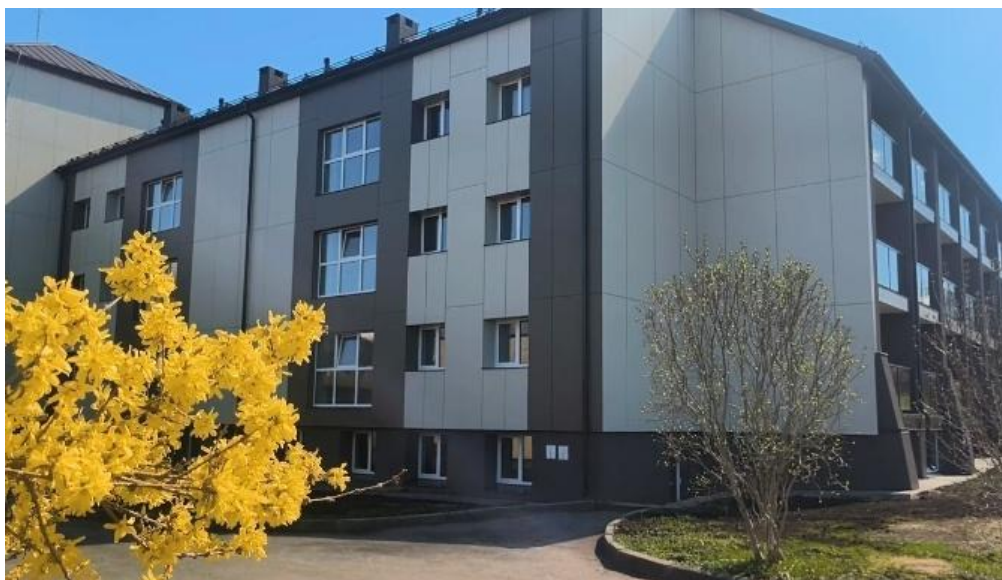
Attēls nr. 11., Pansionāta “Lauciene” “A” korpusa pēc renovācijas
