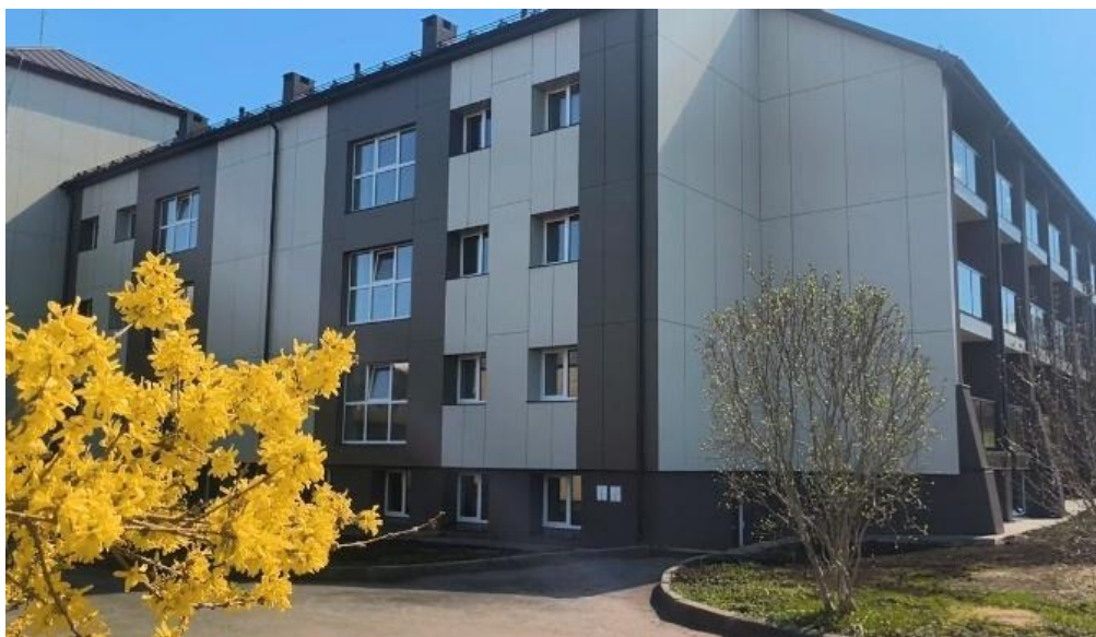
Attēls nr. 10., Pansionāta “Lauciene” “A” korpusa pēc renovācijas
